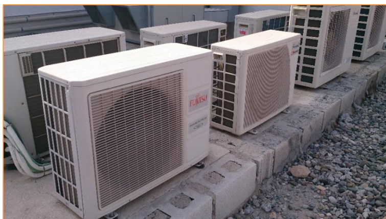
Imagen 14 Equipos de producción de frío y calor para climatización – Equipos en cubierta y oficina taller RSU
