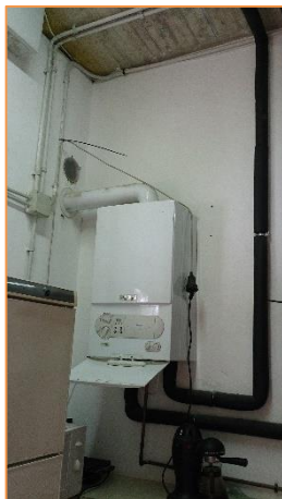
Imagen 7 Instalación de apoyo para generación de ACS – Caldera mural estanca
