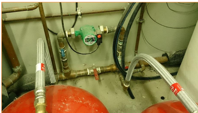
Imagen 16 Grupos de bombeo - Bomba recirculación ACS y antilegionella
