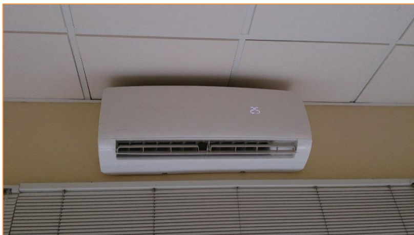
Imagen 20 Tipología de unidades interiores instaladas – Sistema autónomo de expansión directa tipo cassette y pared
