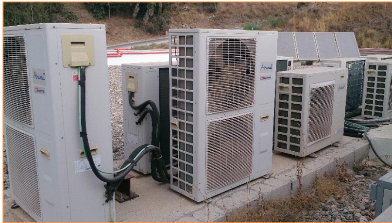
Imagen 12 Equipos de producción de frío y calor para climatización - Equipos en cubierta
