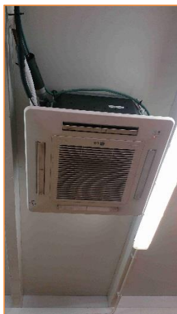
Imagen 20 Tipología de unidades interiores instaladas – Sistema autónomo de expansión directa tipo cassette y pared
