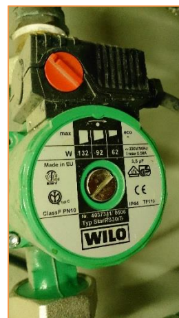
Imagen 16 Grupos de bombeo - Bomba recirculación ACS y antilegionella
