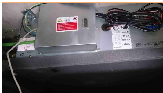
Imagen 21 Tipología de unidades interiores instaladas – Sistema autónomo de expansión directa tipo conductos
