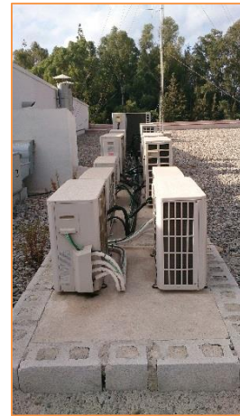
Imagen 12 Equipos de producción de frío y calor para climatización - Equipos en cubierta
