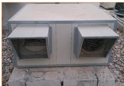
Imagen 22 Tipología de UTAs instaladas – Climatizadora Tipo 1
