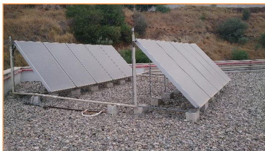
Imagen 5 Instalación solar térmica – Captadores solares planos
