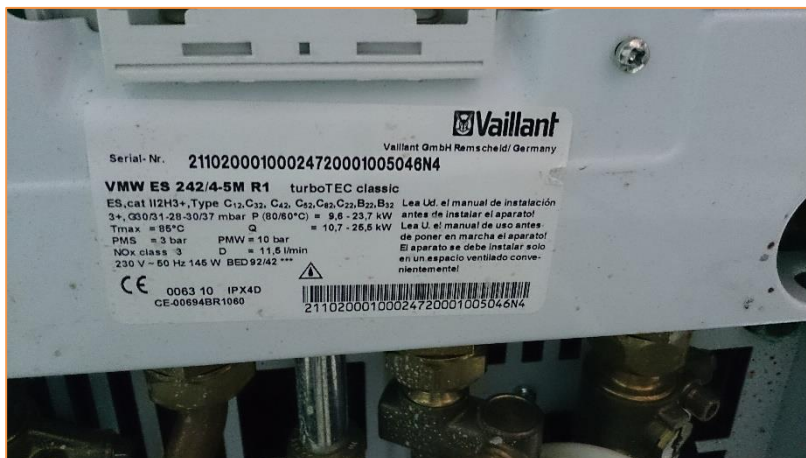
Imagen 7 Instalación de apoyo para generación de ACS – Caldera mural estanca
