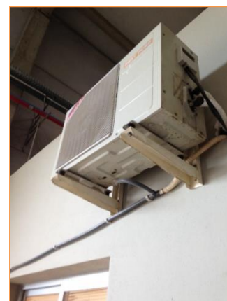
Imagen 14 Equipos de producción de frío y calor para climatización – Equipos en cubierta y oficina taller RSU
