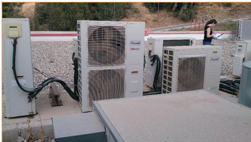
Imagen 13 Equipos de producción de frío y calor para climatización - Equipos en cubierta
