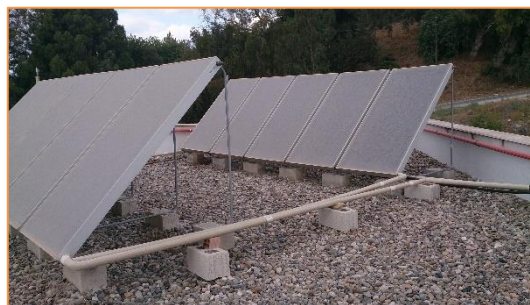
Imagen 5 Instalación solar térmica – Captadores solares planos
