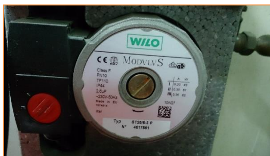
Imagen 15 Grupos de bombeo – Primario solar térmica
