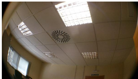
Imagen 21 Tipología de unidades interiores instaladas – Sistema autónomo de expansión directa tipo conductos
