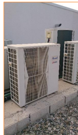
Imagen 13 Equipos de producción de frío y calor para climatización - Equipos en cubierta
