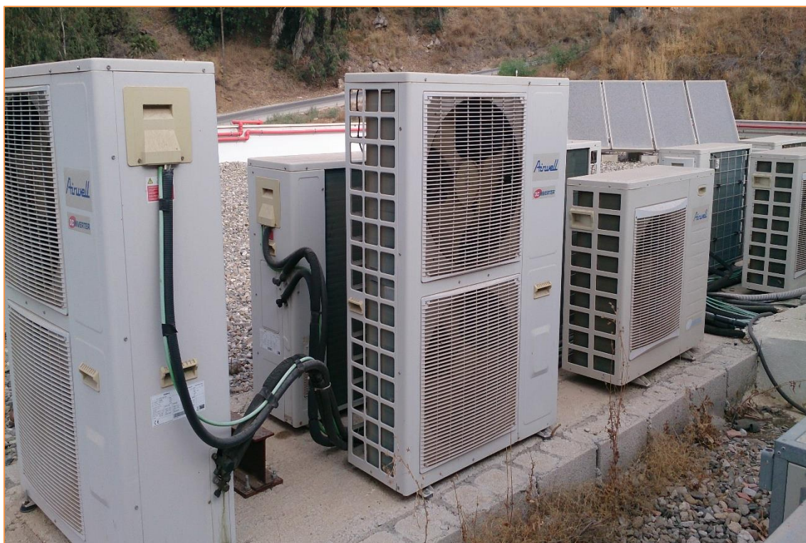
Fotografía 54. Unidades exteriores Splits Cubierta
