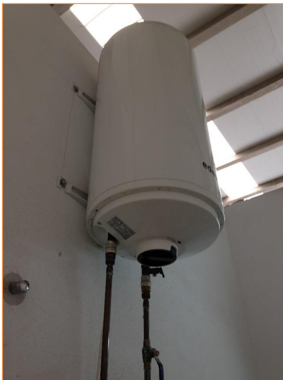
Fotografía 60. Termo acumulador eléctrico Aseo Taller RSU
