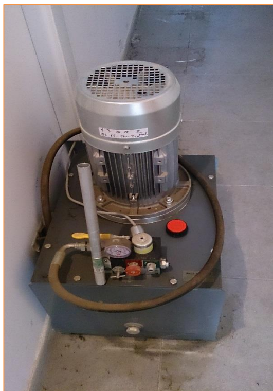
Fotografía 25. Motor Plataforma Elevadora Minusválidos
