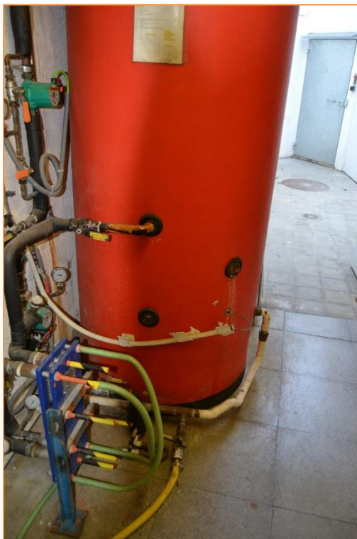
Fotografía 51. Intercambiador de placas y acumulador Cuarto de Calderas
