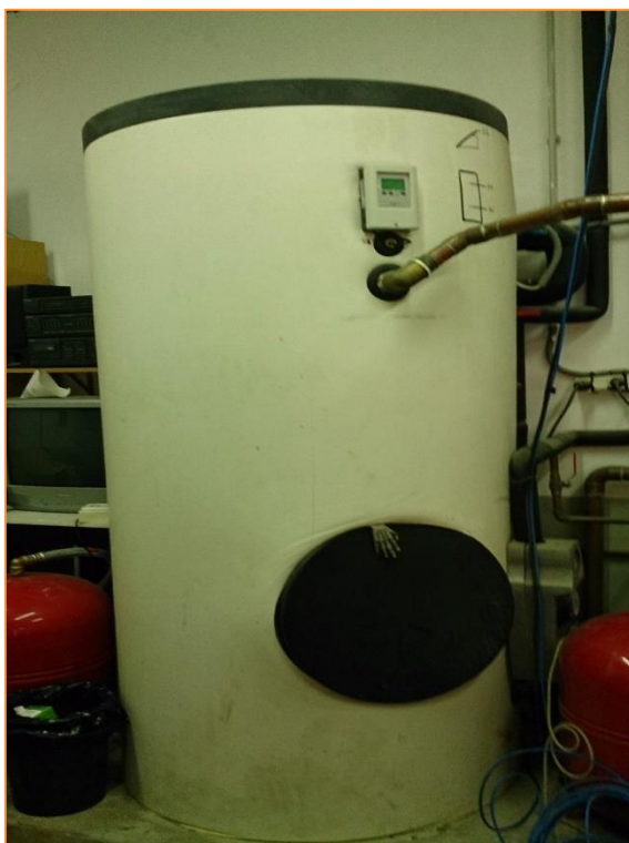
Fotografía 50. Depósito acumulador Cuarto de Calderas
