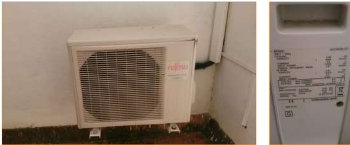
Imagen 5 Equipos de producción de frío y calor para climatización. Split 3 – Patio
