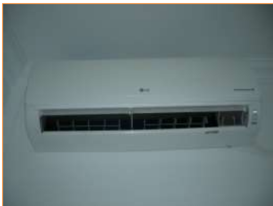
Imagen 19 Tipología de unidades interiores instaladas. Tipo PARED
