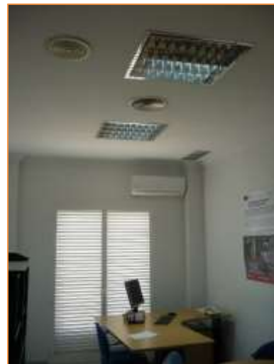
Imagen 18 Tipología de unidades interiores instaladas. Tipo CONDUCTOS
