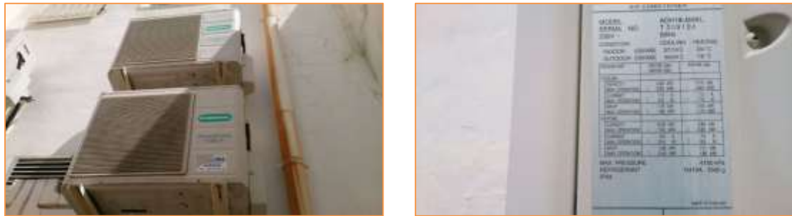
Imagen 4 Equipos de producción de frío y calor para climatización. Splits 1, 2, 4, 5, 6 - Patio
