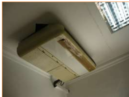
Imagen 20 Tipología de unidades interiores instaladas. Tipo TECHO
