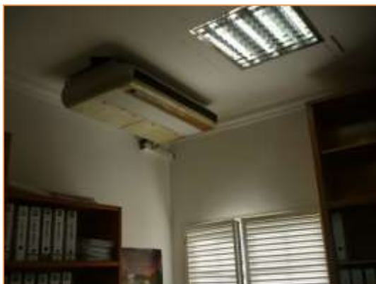
Imagen 20 Tipología de unidades interiores instaladas. Tipo TECHO
