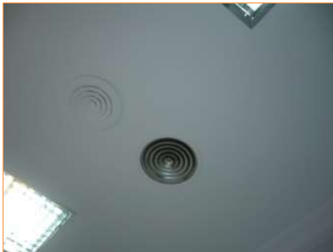
Imagen 18 Tipología de unidades interiores instaladas. Tipo CONDUCTOS
