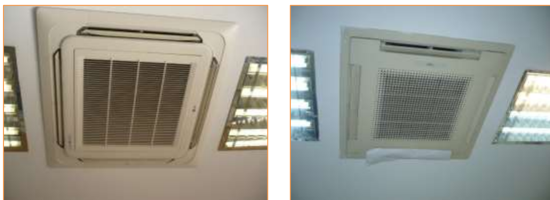
Imagen 17 Tipología de unidades interiores instaladas. Tipo CASSETTE
