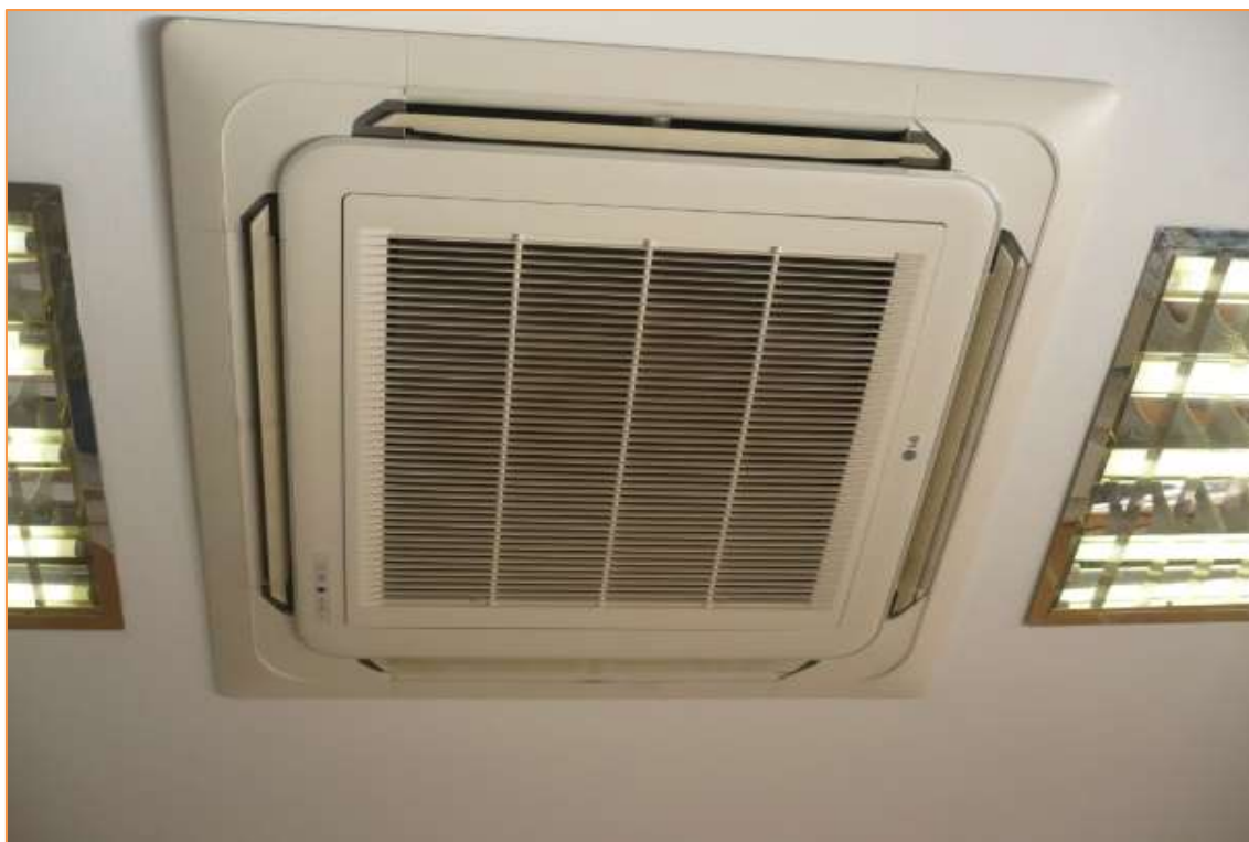
Fotografía 74. Unidades interiores de climatización. Tipo Cassette
