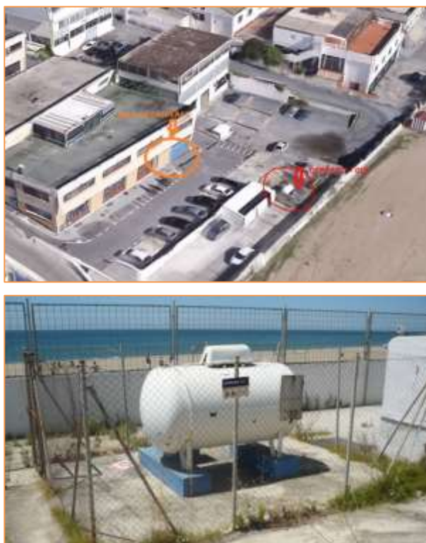
Imagen 30 Consumos térmicos. Depósito exterior de GLP. Edificio secundario
