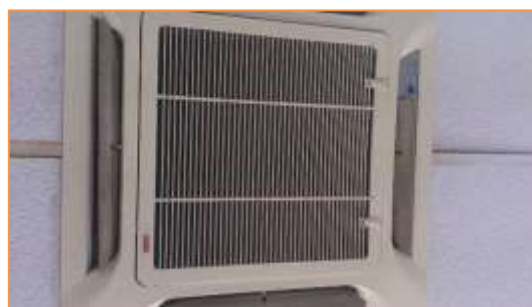
Imagen 16 Tipología de unidades interiores instaladas – Cassette - Sala 092 – Edificio principal
