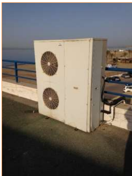
Imagen 17 Tipología de UTAs instaladas – Equipo partido de expansión directa – Zona gimnasio – Edificio secundario
