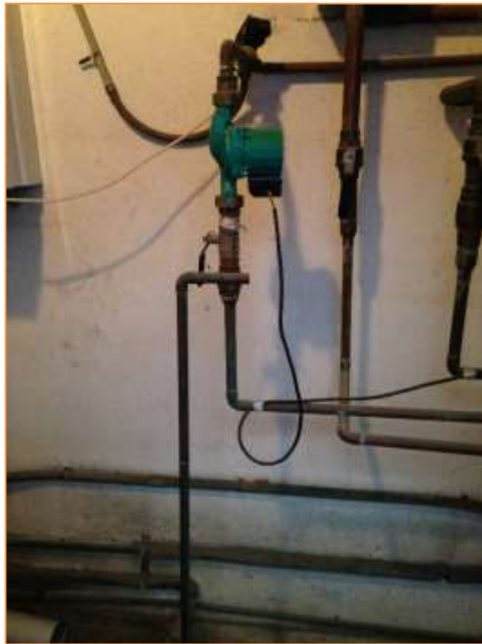
Imagen 14 Grupos de bombeo – Recirculación de ACS – Edificio secundario
