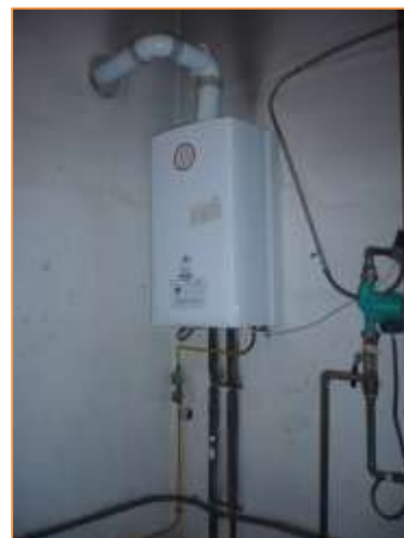
Imagen 5 Equipos de producción de calor para ACS. Caldera mural - Edificio secundario – Planta baja
