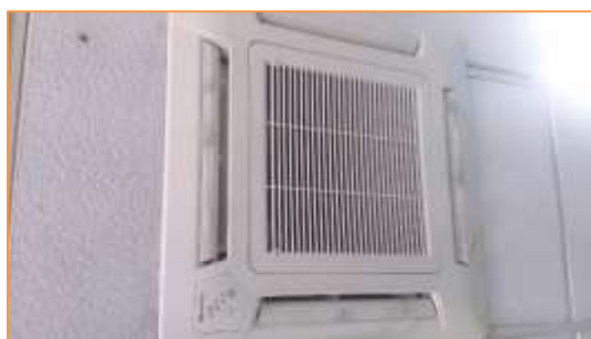
Imagen 16 Tipología de unidades interiores instaladas – Cassette - Sala 092 – Edificio principal
