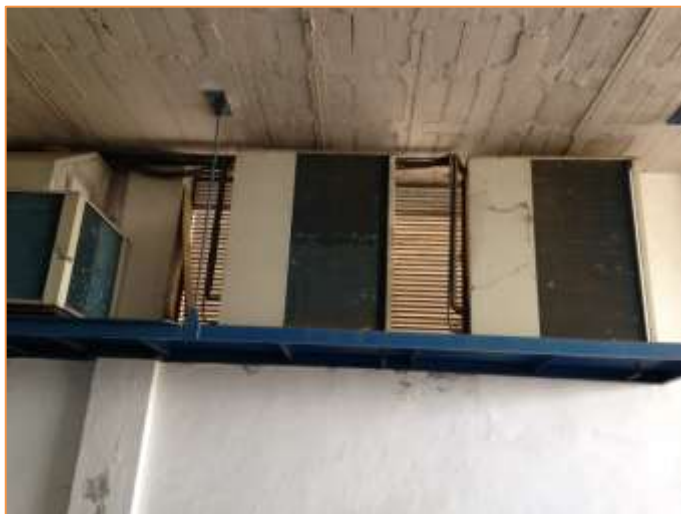
Imagen 13 Equipos de producción de frío y calor para climatización. Rampa – Edificio secundario
