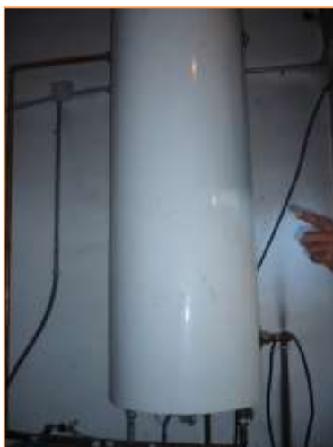
Imagen 29 Equipos de producción de calor para ACS. Acumulador 185 litros. Edificio secundario – Planta baja
