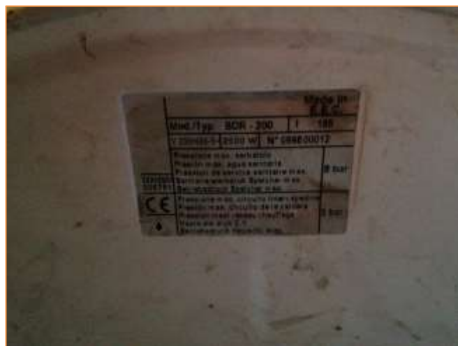
Imagen 7 Equipos de producción de calor para ACS. Acumulador 185 litros. Edificio secundario – Planta baja
