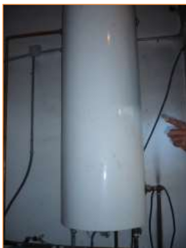
Imagen 7 Equipos de producción de calor para ACS. Acumulador 185 litros. Edificio secundario – Planta baja
