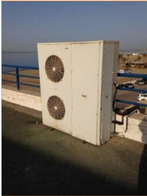
Imagen 10 Equipos de producción de frío y calor para climatización. Equipo partido. Gimnasio. Edificio secundario
