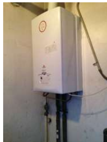
Imagen 6 Equipos de producción de calor para ACS. Caldera mural - Edificio secundario – Planta baja
