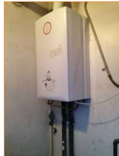
Imagen 28 Equipos de producción de calor para ACS. Caldera mural - Edificio secundario – Planta baja
