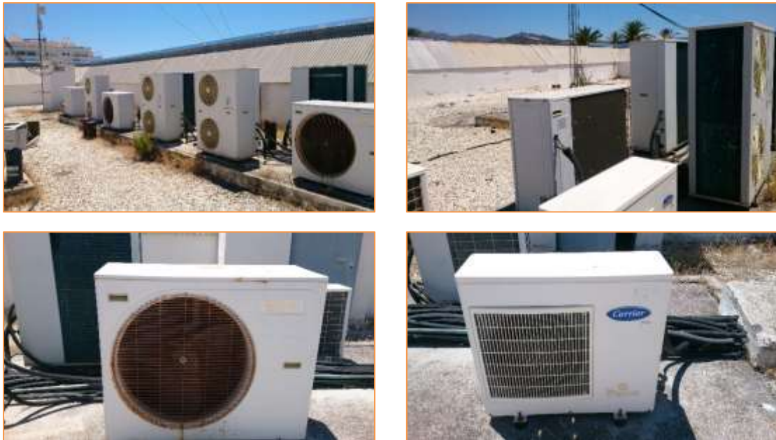
Imagen 9 Equipos de producción de frío y calor para climatización. Edificio Principal – Cubierta
