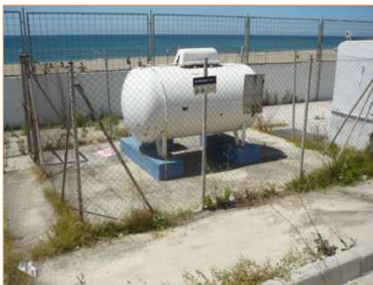
Imagen 20 Consumos térmicos. Depósito exterior de GLP. Edificio secundario
