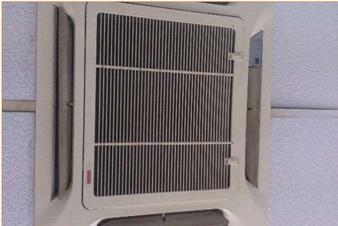
Fotografía 62. Unidades Interiores de Frio Calor. Tipo Cassette
