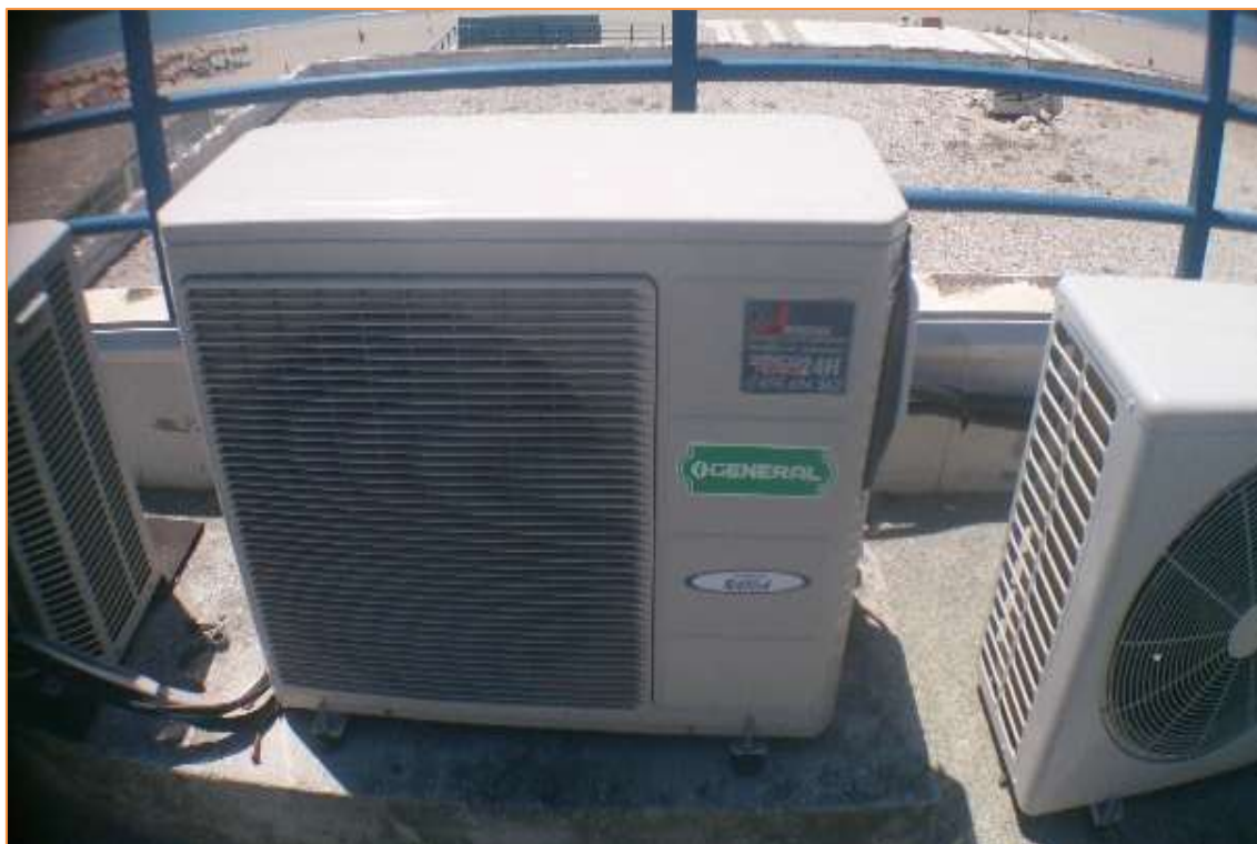
Fotografía 59. Unidades Exteriores de Frio y Calor Terraza
