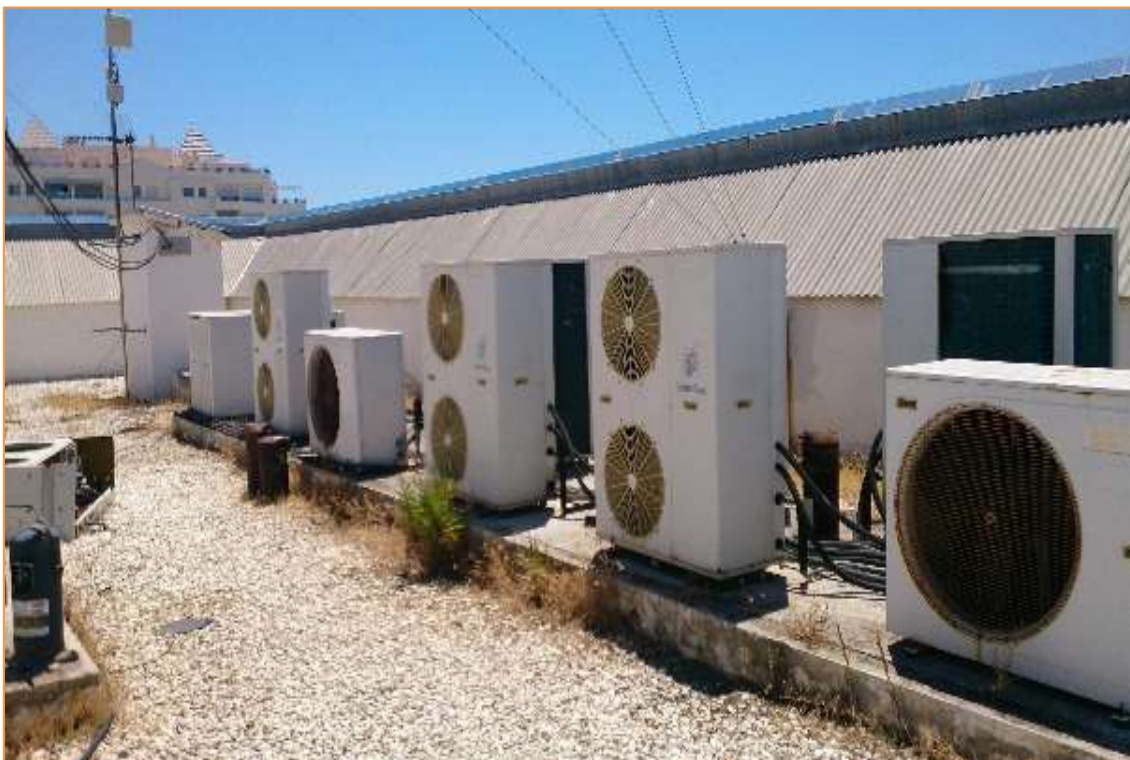
Fotografía 61. Unidades exteriores Splits Cubierta
