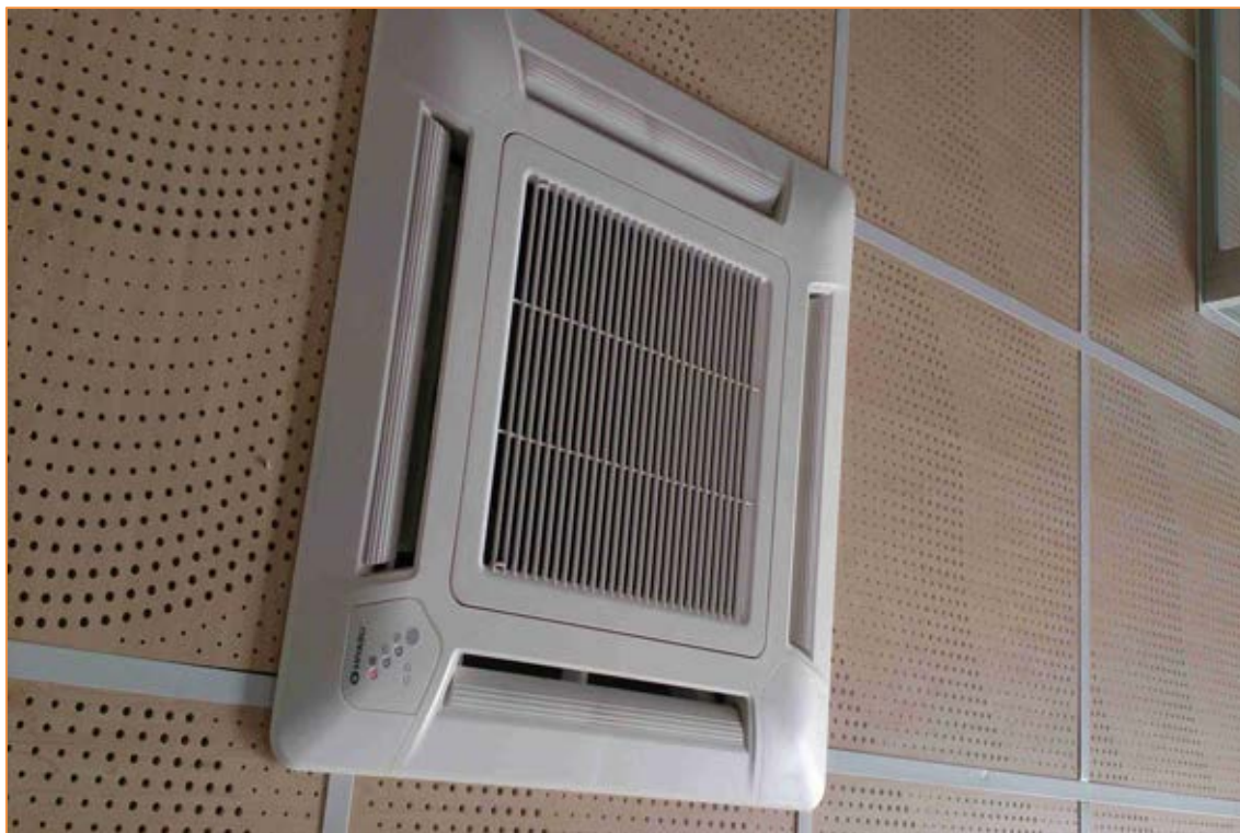
Fotografía 67. Unidades Interiores Tipo Cassette en Protocolo
