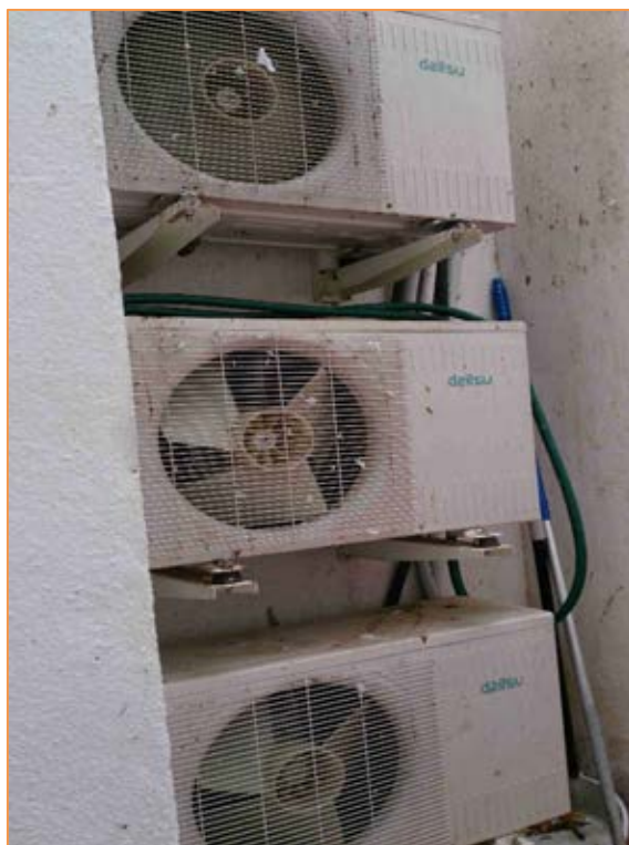
Fotografía 61. Unidades exteriores Splits Fachada Patio
