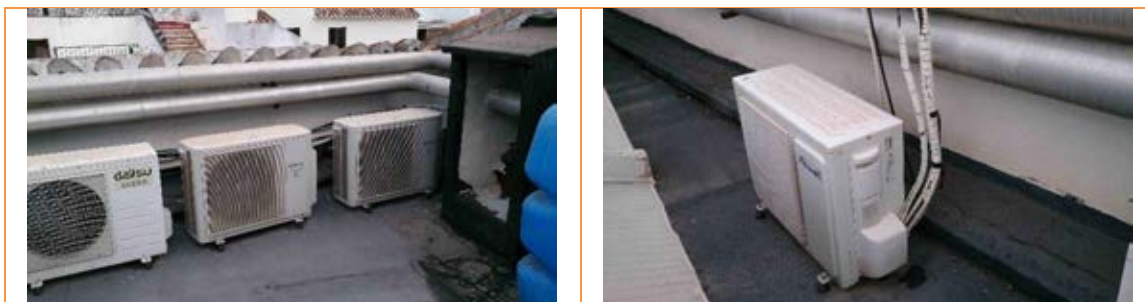
Imagen 4 Equipos de producción de frío y calor para climatización
