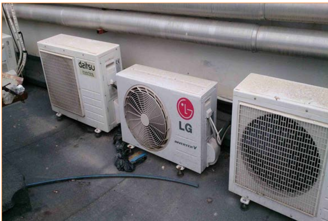
Fotografía 59. Unidades exteriores Splits Cubierta
