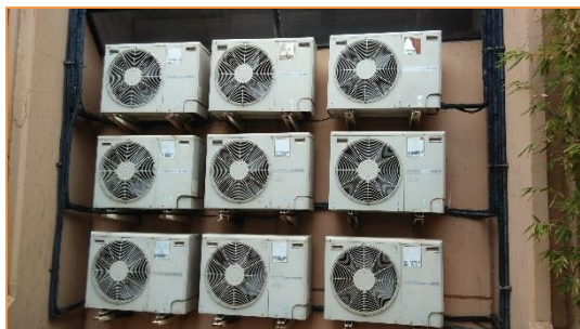
Imagen 8 Equipos de producción de frío y calor para climatización. Sistema autónomo de expansión directa tipo BdC – Split.Cassette
