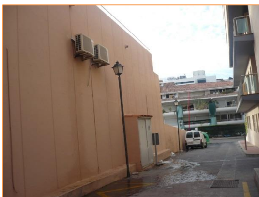
Imagen 9 Equipos de producción de frío y calor para climatización. Sistema autónomo de expansión directa tipo BdC – MultiSplit. 2xPared
