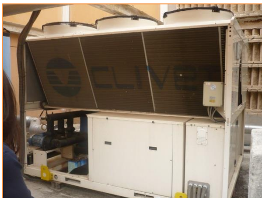
Imagen 11 Equipos de producción de frío y calor para climatización. Enfriadora
