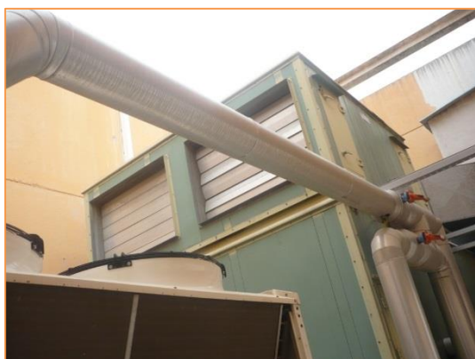
Imagen 16 Tipología de UTAs instaladas
