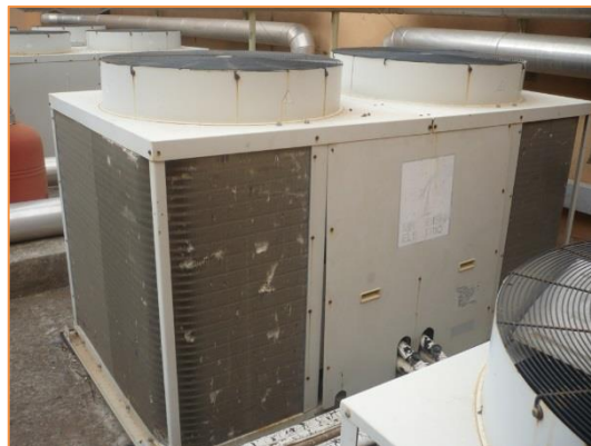
Imagen 7 Equipos de producción de frío y calor para climatización. Sistema autónomo de expansión directa tipo BdC – Split. Conductos
