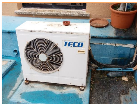
Imagen 9 Equipos de producción de frío y calor para climatización. Sistema autónomo de expansión directa tipo BdC – MultiSplit. 2xPared
