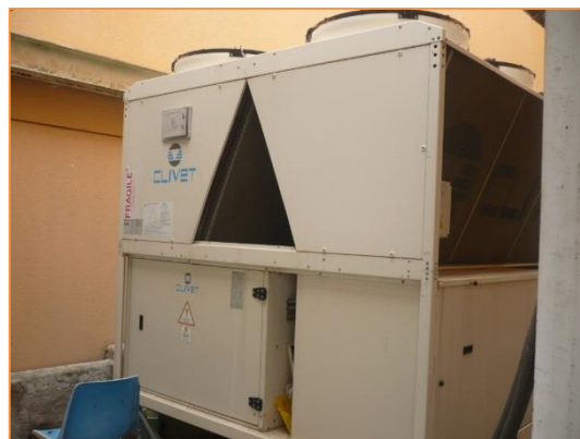
Imagen 11 Equipos de producción de frío y calor para climatización. Enfriadora
