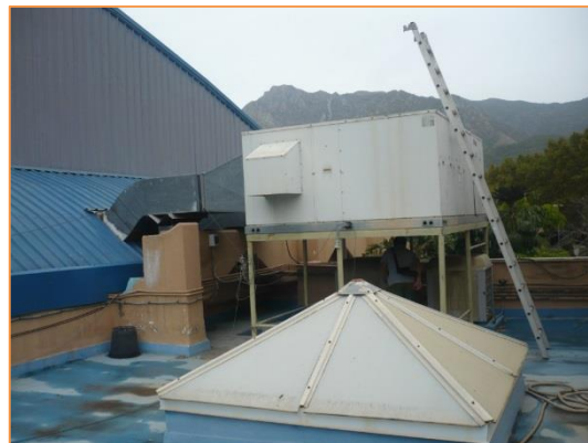
Imagen 10 Equipos de producción de frío y calor para climatización. Rooftop – Compacto. Conductos
