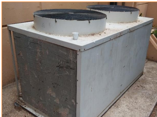
Imagen 7 Equipos de producción de frío y calor para climatización. Sistema autónomo de expansión directa tipo BdC – Split. Conductos
