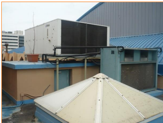
Imagen 10 Equipos de producción de frío y calor para climatización. Rooftop – Compacto. Conductos
