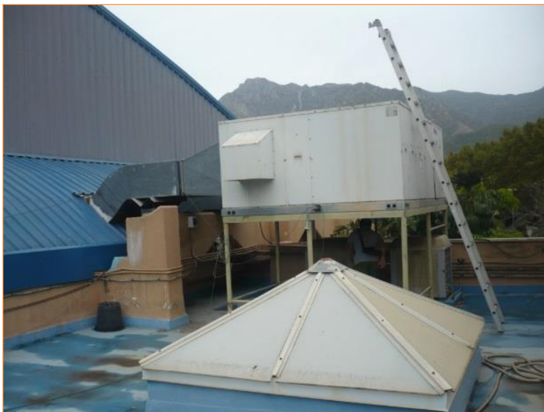
Fotografía 51. Rooftop – Compacto. Conductos
