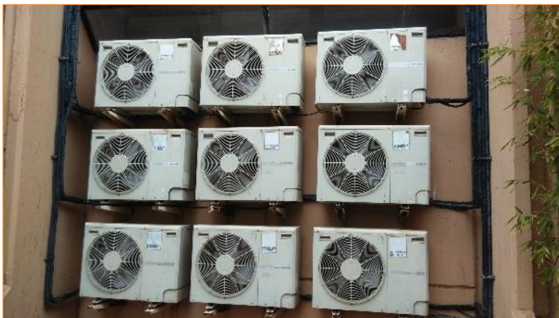
Fotografía 49. Sistemas autónomos de expansión directa tipo BdC – Split. Cassette
