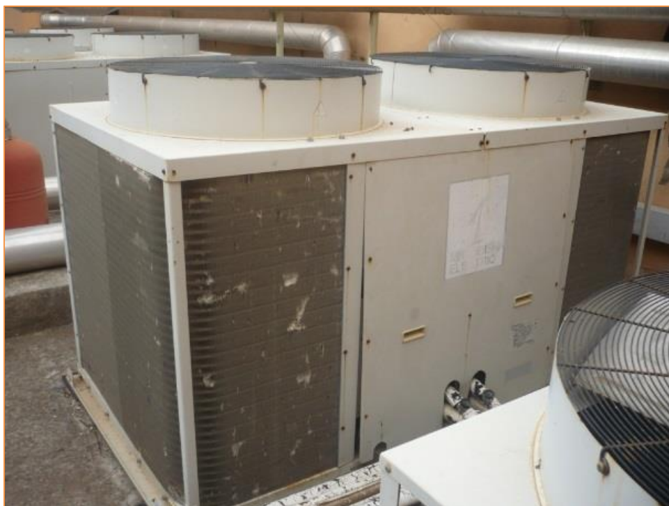
Fotografía 48. Sistema autónomo de expansión directa tipo BdC – Split. Conductos
