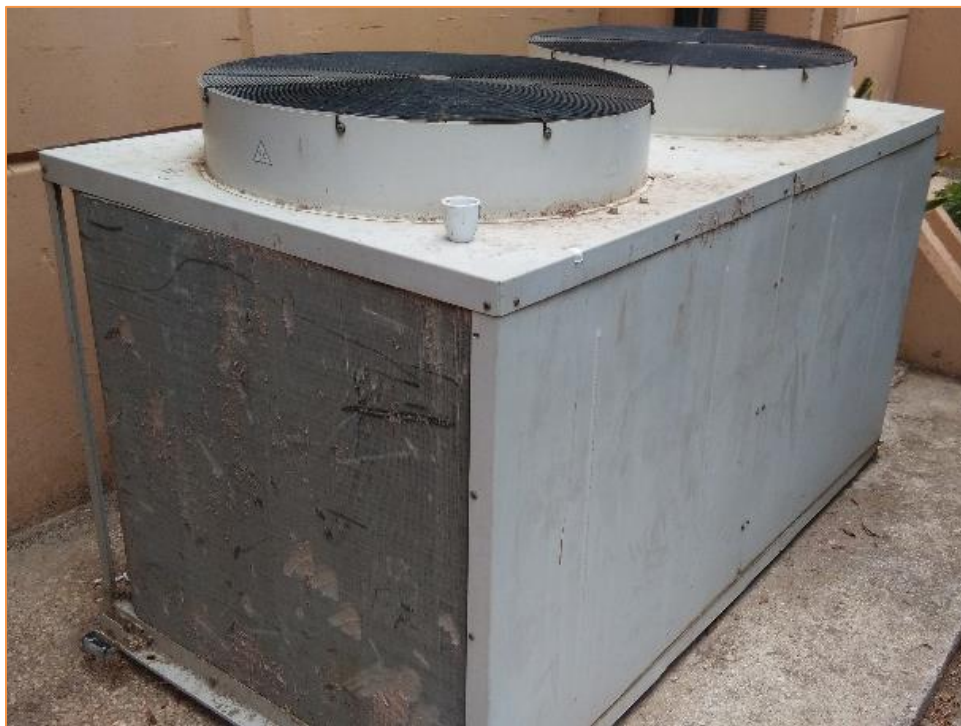
Fotografía 47. Sistema autónomo de expansión directa tipo BdC – Split. Conductos
