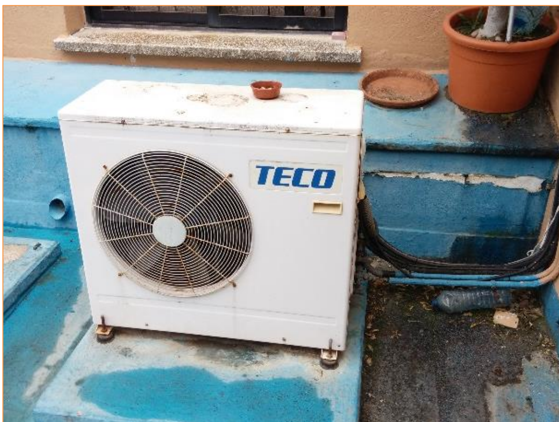
Fotografía 50. Sistema autónomo de expansión directa tipo BdC – MultiSplit. 2xPared
