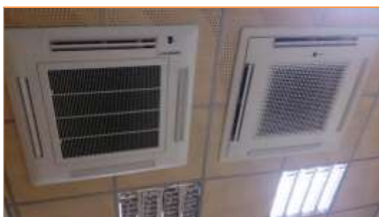
Imagen 11 Tipología de unidades interiores instaladas. Split 4– Sala fría
