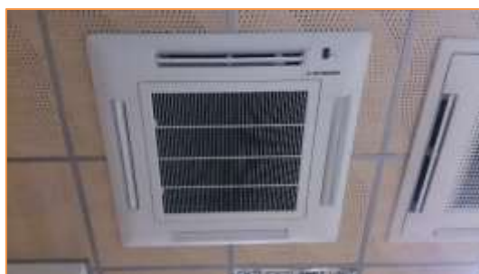
Imagen 11 Tipología de unidades interiores instaladas. Split 4– Sala fría
