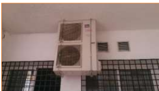
Imagen 7 Equipos de producción de frío y calor para climatización. Split 4 - Sala fría
