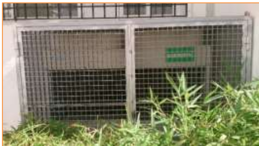
Imagen 4 Equipos de producción de frío y calor para climatización. Enfriadora 1
