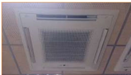
Imagen 10 Tipología de unidades interiores instaladas. Split 3– Sala fría
