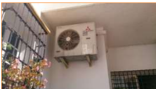
Imagen 6 Equipos de producción de frío y calor para climatización. Split 3 - Sala fría
