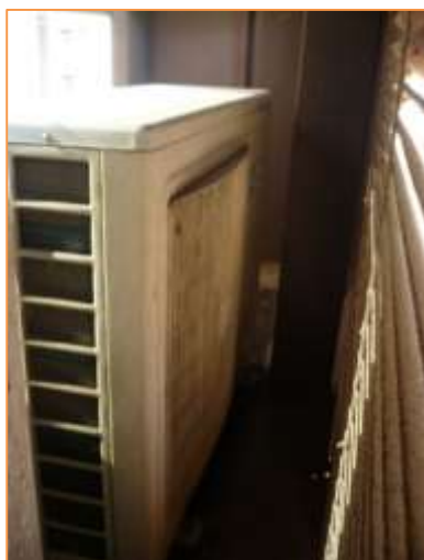
Imagen 6 Equipos de producción de frío y calor para climatización. Split 3 – Despacho 4 Planta 1
