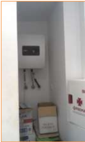
Imagen 5 Termos acumuladores eléctricos. Cuarto de limpieza – Planta 2
