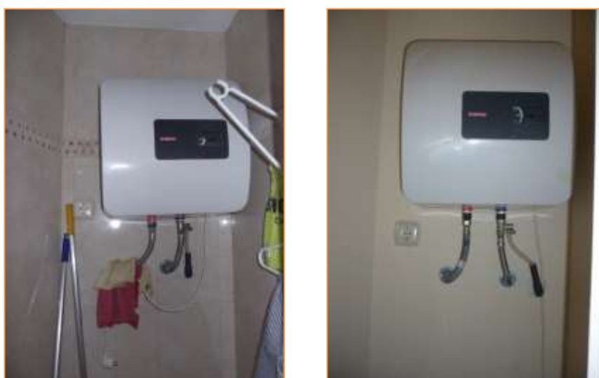
Imagen 4 Termos acumuladores eléctricos. Aseo 1 – Planta 1 y Cuarto de limpieza – Planta 3
