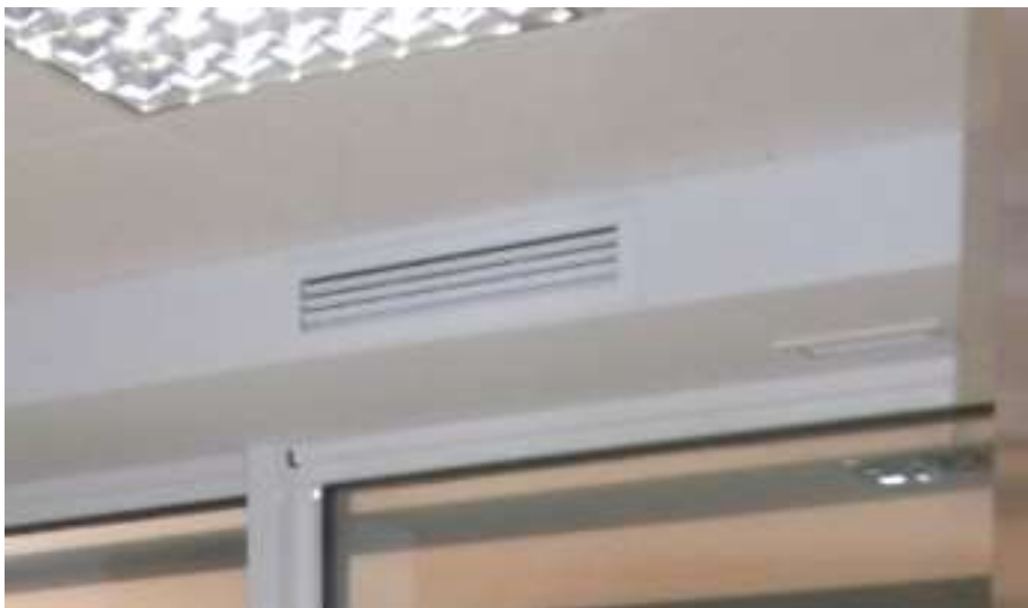
Fotografía 55. Unidad interior Split de conductos
