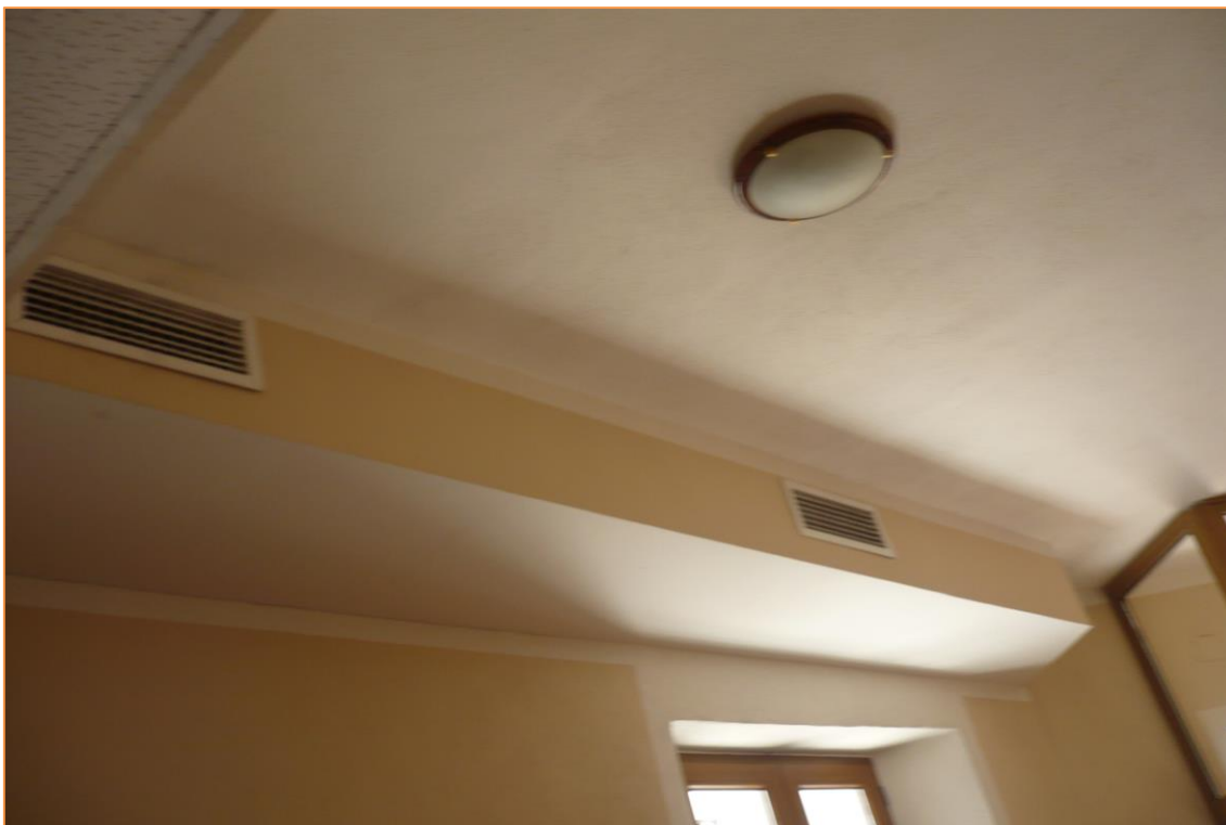
Fotografía 41. Unidades Interiores Tipo Conductos
