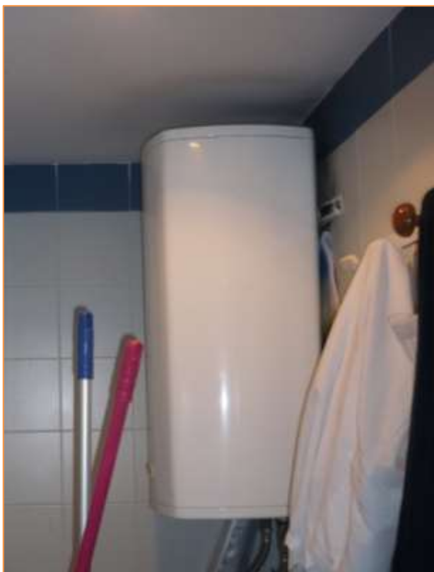
Fotografía 69. Termo acumulador eléctrico Cuarto limpieza
