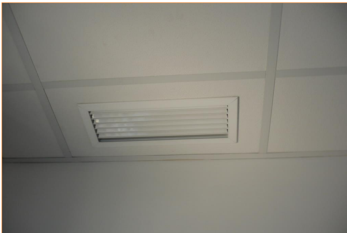
Fotografía 38. Unidades Interiores Tipo Conductos
