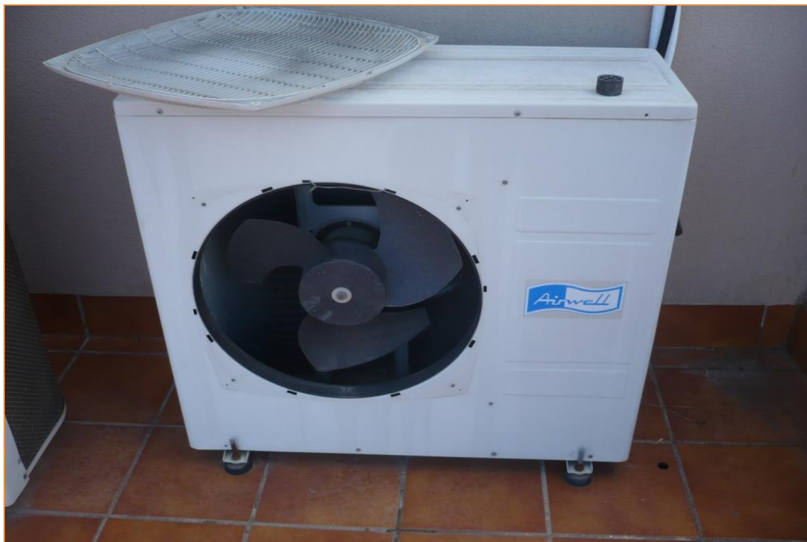
Fotografía 35. Unidades exteriores Splits Cubierta
