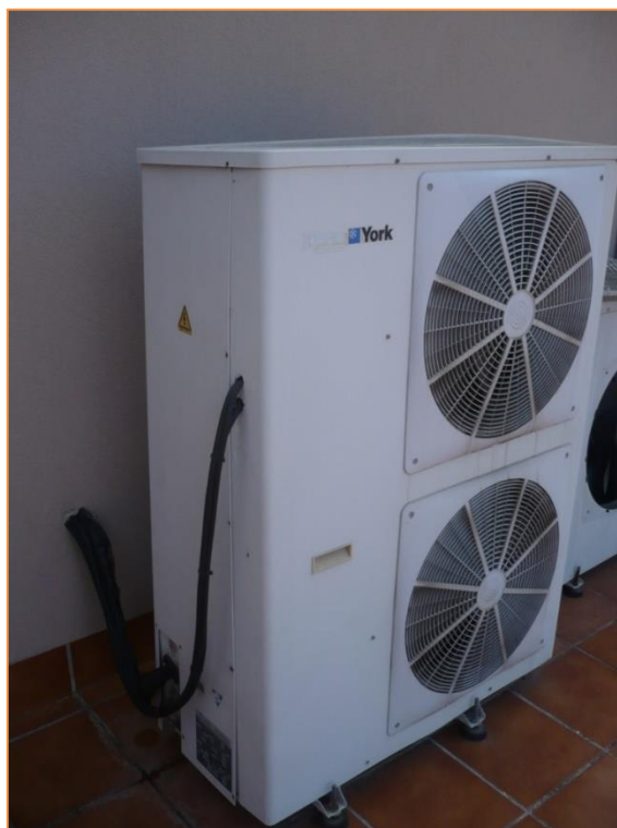
Fotografía 36. Unidades exteriores Splits Cubierta
