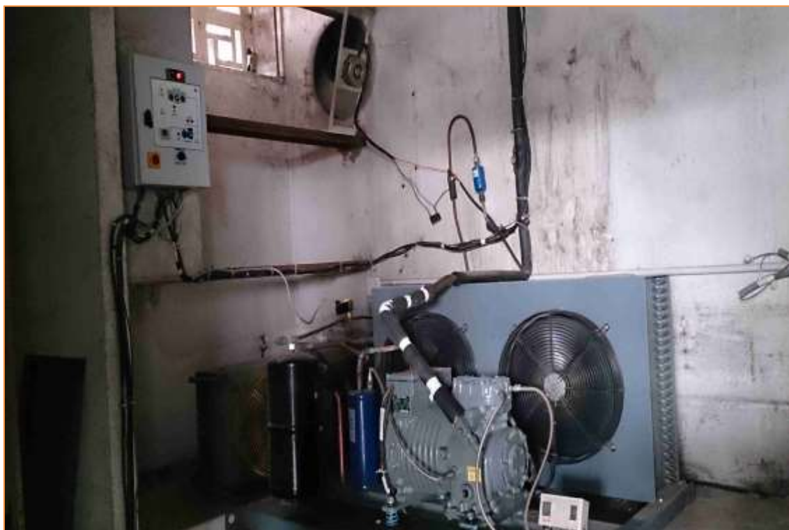
Fotografía 21. Unidades Split Sala de Máquinas
