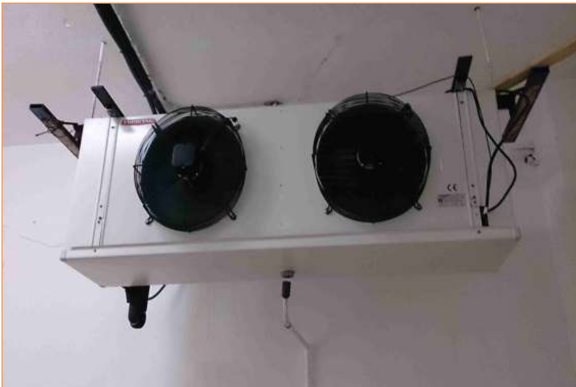
Fotografía 23. Evaporadores Cámaras Frigorífica
