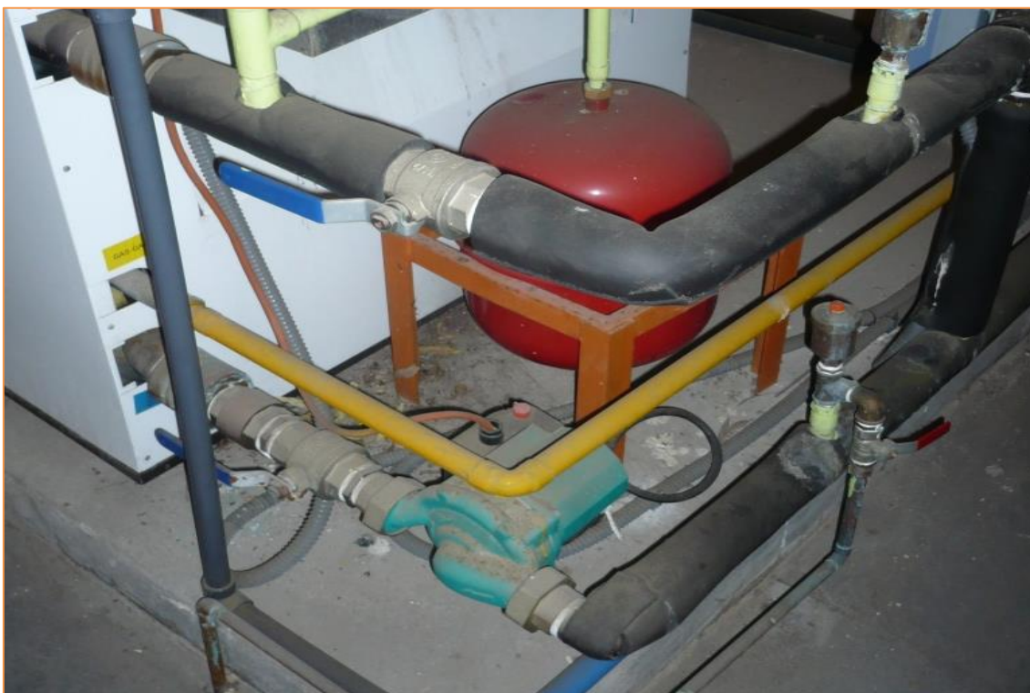
Fotografía 29. Equipo de Bombeo Sala de Caldera
