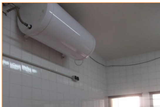
Imagen 4 Termos acumuladores eléctricos –Aseo adaptado y aseo 5
