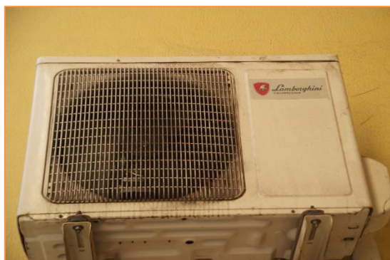
Imagen 5 Equipos de producción de frío y calor para climatización – Sistema autónomo de expansión directa tipo BdC (Split 1x1)
