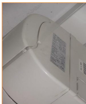
Imagen 5 Equipos de producción de frío y calor para climatización – Sistema autónomo de expansión directa tipo BdC (Split 1x1)
