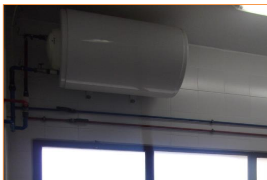
Imagen 4 Termos acumuladores eléctricos –Aseo adaptado y aseo 5
