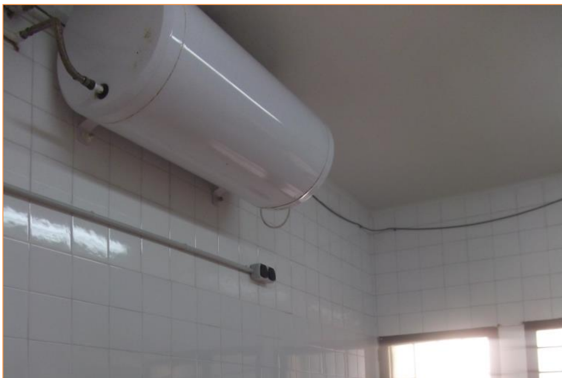
Fotografía 41. Termo acumulador eléctrico Aseo Adaptado
