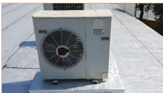
Imagen 11 Equipos de producción de frío y calor para climatización - Sistemas autónomos de expansión directa tipo BdC
