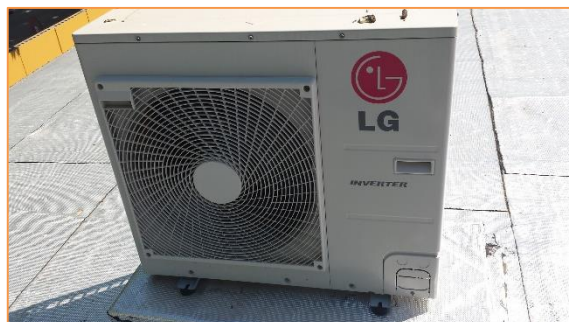
Imagen 9 Equipos de producción de frío y calor para climatización - Sistemas autónomos de expansión directa tipo BdC
