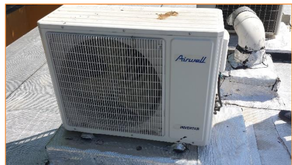
Imagen 8 Equipos de producción de frío y calor para climatización - Sistemas autónomos de expansión directa tipo BdC
