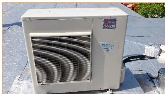
Imagen 12 Equipos de producción de frío y calor para climatización - Sistemas autónomos de expansión directa tipo BdC
