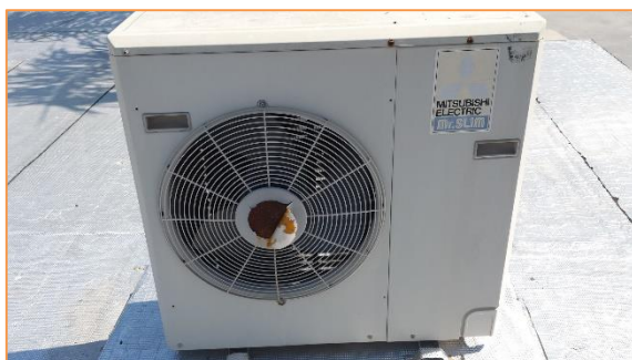
Imagen 12 Equipos de producción de frío y calor para climatización - Sistemas autónomos de expansión directa tipo BdC
