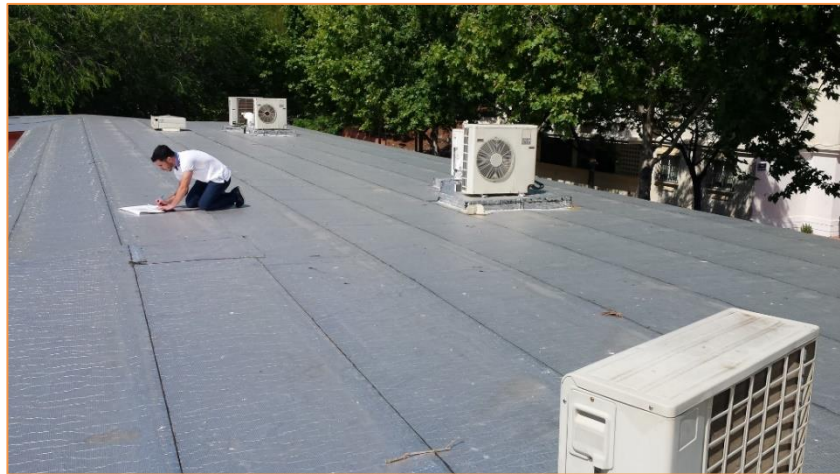
Imagen 6 Equipos de producción de frío y calor para climatización – Sistemas autónomos de expansión directa tipo BdC
