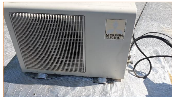
Imagen 7 Equipos de producción de frío y calor para climatización - Sistemas autónomos de expansión directa tipo BdC
