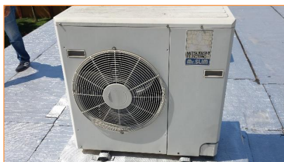
Imagen 11 Equipos de producción de frío y calor para climatización - Sistemas autónomos de expansión directa tipo BdC
