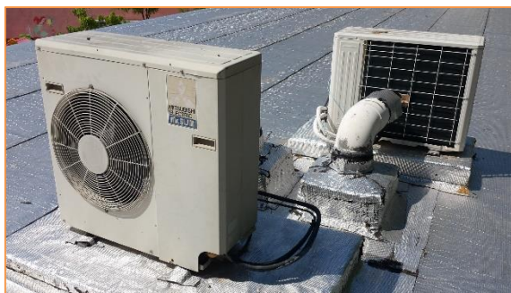
Imagen 8 Equipos de producción de frío y calor para climatización - Sistemas autónomos de expansión directa tipo BdC
