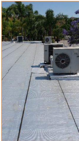
Imagen 6 Equipos de producción de frío y calor para climatización – Sistemas autónomos de expansión directa tipo BdC
