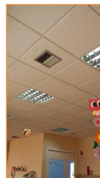
Imagen 13 Tipología de unidades interiores instaladas – Cassette y difusores de aire
