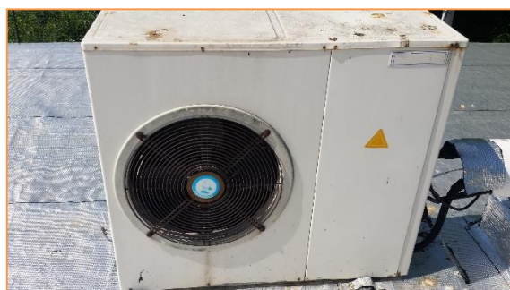
Imagen 10 Equipos de producción de frío y calor para climatización - Sistemas autónomos de expansión directa tipo BdC
