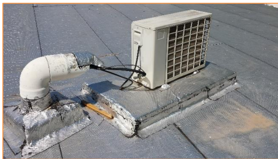
Imagen 7 Equipos de producción de frío y calor para climatización - Sistemas autónomos de expansión directa tipo BdC
