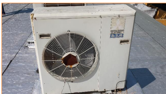
Imagen 10 Equipos de producción de frío y calor para climatización - Sistemas autónomos de expansión directa tipo BdC
