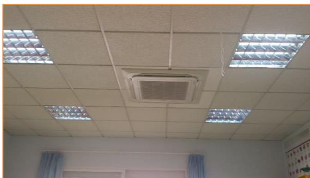
Imagen 13 Tipología de unidades interiores instaladas – Cassette y difusores de aire
