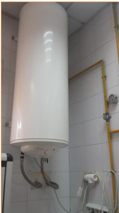
Fotografía 19. Termo-acumulador eléctrico
