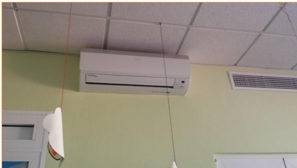
Fotografía 24. Unidades interiores tipo Split y conductos
