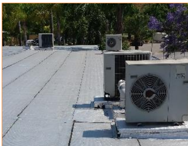
Fotografía 20. Unidades Exteriores de Splits en cubierta
