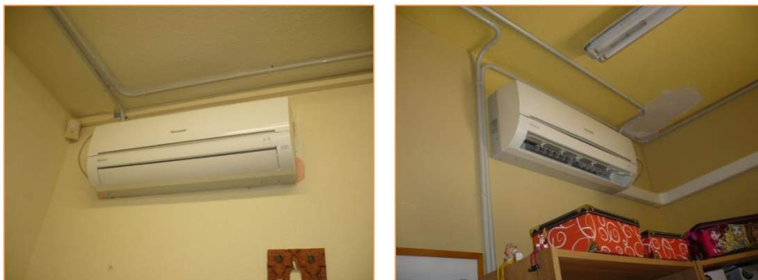
Imagen 8 Tipología de unidades interiores instaladas – Despacho directora y sala de profesores
