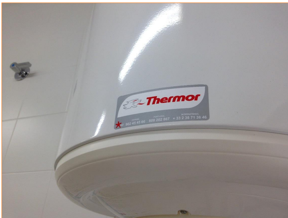
Fotografía 27. Termo de acumulador electrico
