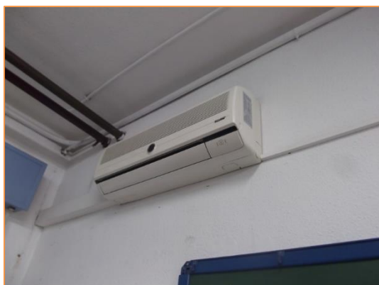
Imagen 9 Tipología de unidades interiores instaladas – De pared
