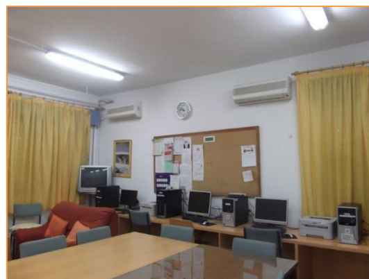
Imagen 9 Tipología de unidades interiores instaladas – De pared
