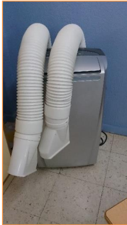
Imagen 7 Equipos de producción de frío y calor para climatización – Unidad compacta de aire acondicionado portátil
