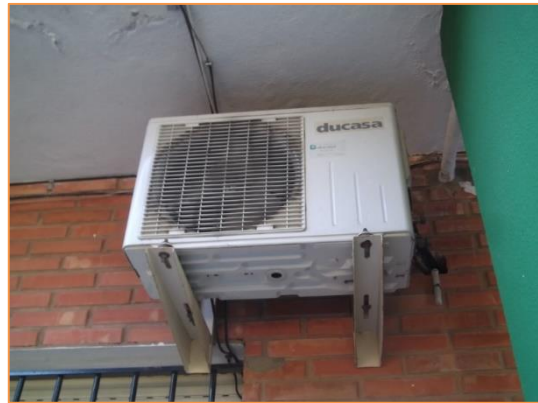
Imagen 6 Equipos de producción de frío y calor para climatización – Sistemas autónomos de expansión directa tipo BdC
