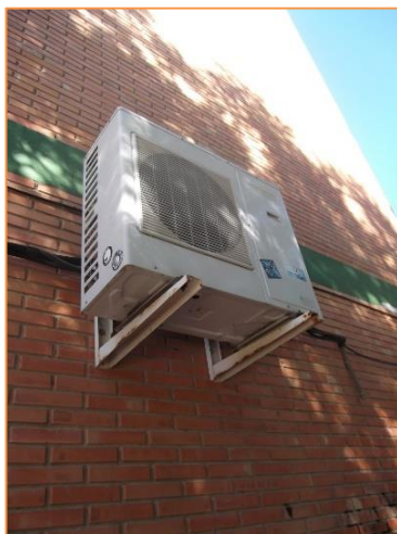
Imagen 8 Equipos de producción de frío y calor para climatización - Sistema autónomo de expansión directa tipo BdC
