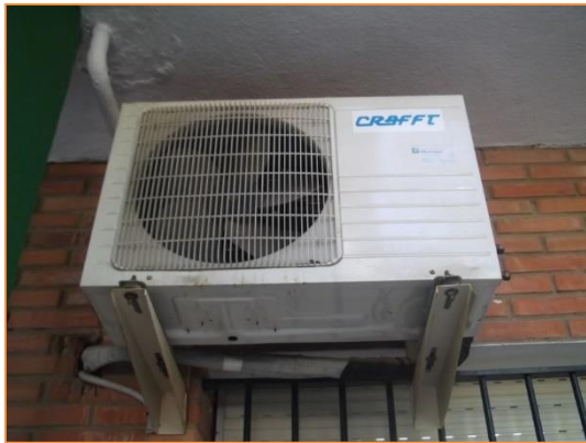
Imagen 6 Equipos de producción de frío y calor para climatización – Sistemas autónomos de expansión directa tipo BdC
