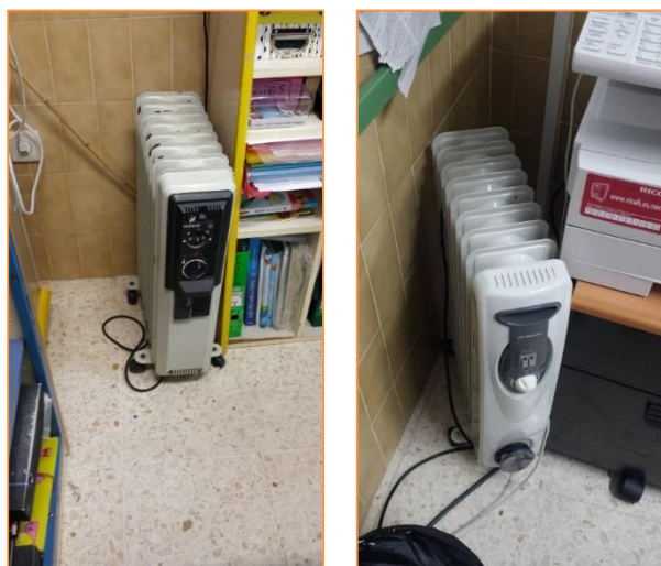
Imagen 5 Tipología de unidades terminales instaladas
