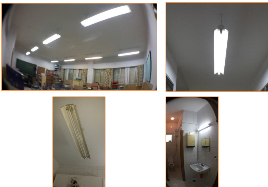
Imagen 6 Tipos de luminarias instaladas
