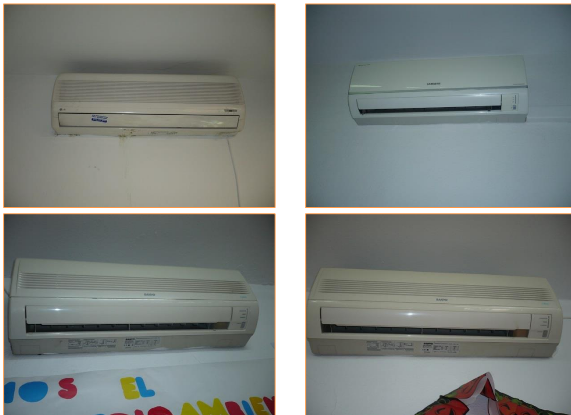
Imagen 9 Tipología de unidades interiores instaladas - Pared
