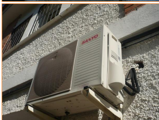
Imagen 8 Equipos de producción de frío y calor para climatización – Sistemas autónomos de expansión directa tipo BdC –Split 1x1
