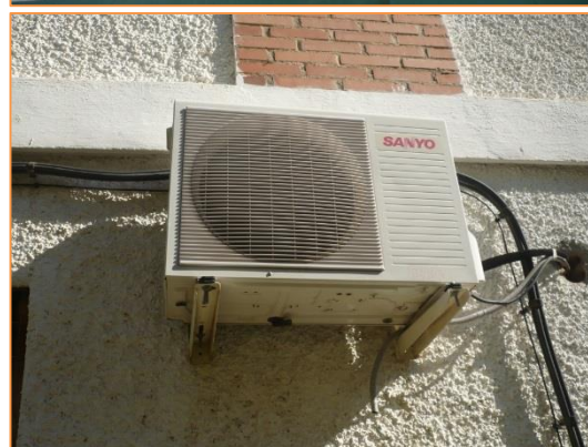
Imagen 8 Equipos de producción de frío y calor para climatización – Sistemas autónomos de expansión directa tipo BdC –Split 1x1
