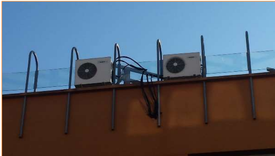
Fotografía 14. Equipos de expansión directa Split
