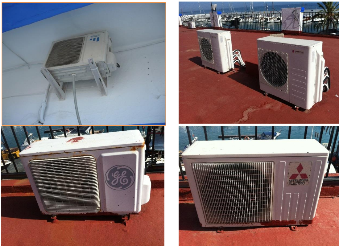
Imagen 4 Equipos de producción de frío y calor para climatización
