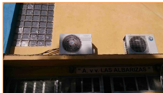
Imagen 7 Equipos de producción de frío y calor para climatización
