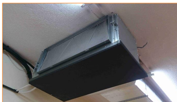
Imagen 9 Tipología de unidades interiores instaladas
