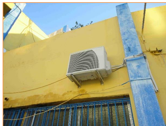
Imagen 6 Equipos de producción de frío y calor para climatización
