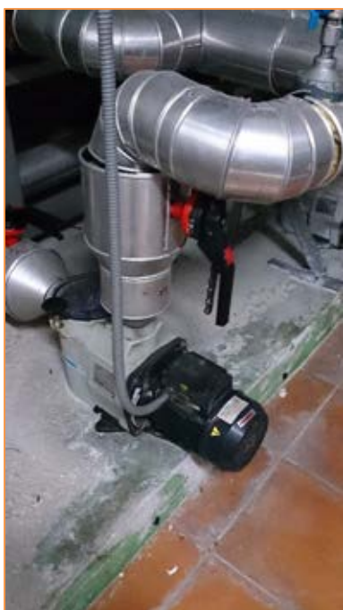
Imagen 31 Grupos de bombeo –Recirculación piscina (B21 y B22)
