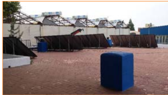
Imagen 13 Instalación solar térmica – Captadores solares planos
