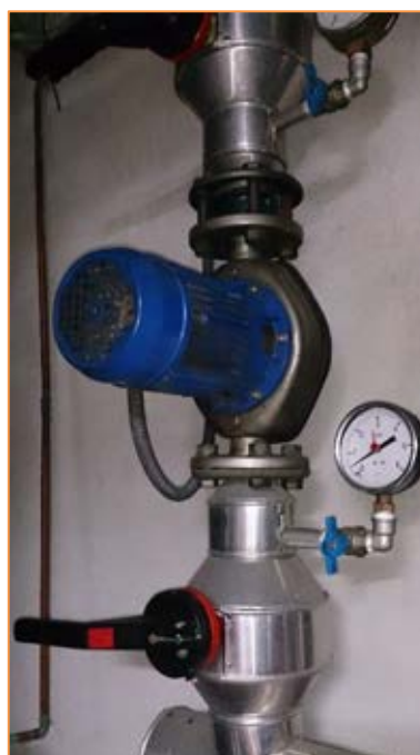
Imagen 36 Grupos de bombeo – Grupo de presión de agua caliente sanitaria (B31 y B32)
