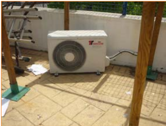
Imagen 19 Equipos de producción de frío y calor para climatización - Sistema autónomo de expansión directa tipo BdC Split 1x1
