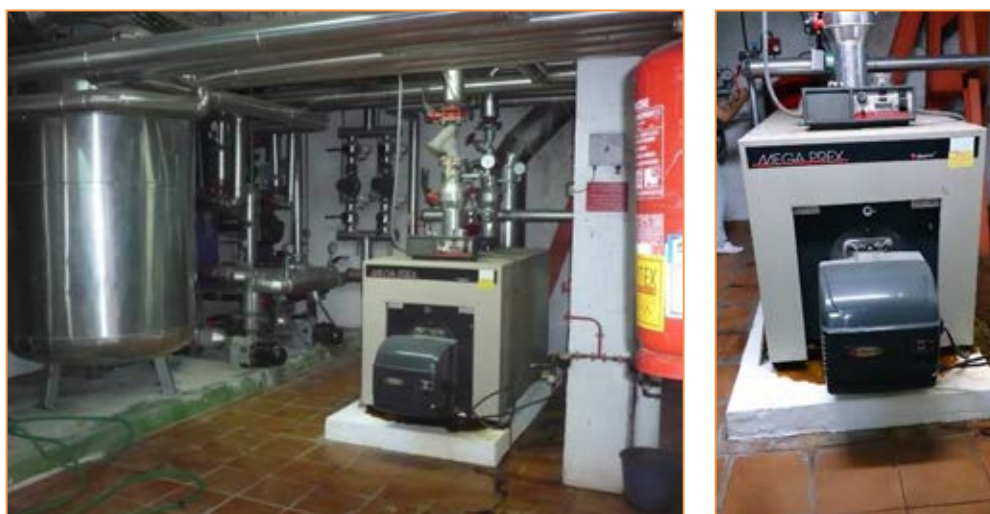
Imagen 16 Instalación de apoyo para generación de ACS
