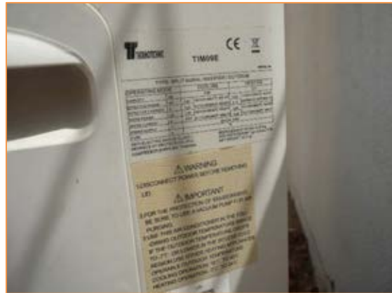
Imagen 19 Equipos de producción de frío y calor para climatización - Sistema autónomo de expansión directa tipo BdC Split 1x1
