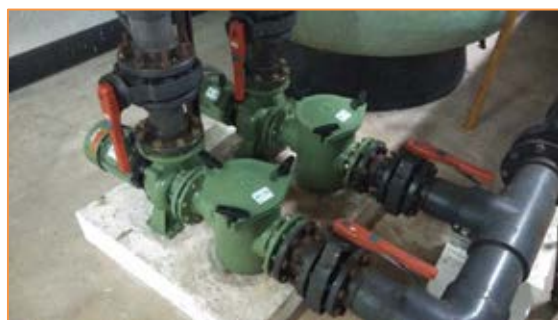
Imagen 33 Grupos de bombeo – Primario depuradora (B25 y B26)
