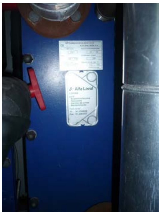
Imagen 53 Intercambiadores de calor – Calentamiento de vaso
