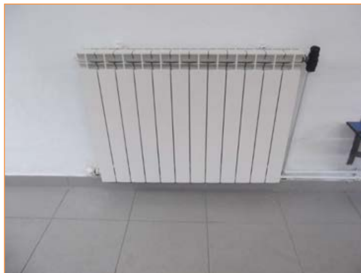
Imagen 38 Tipología de radiadores instalados – Tipo 2
