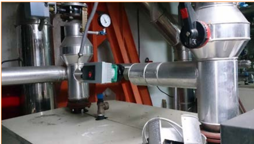
Imagen 32 Grupos de bombeo – Anticondensación caldera (B23 y B24)
