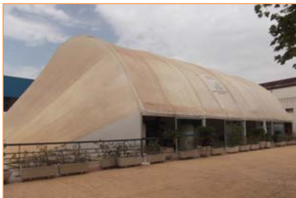
Imagen 5. Envolvente térmica. Arquitectura textil. Piscina
