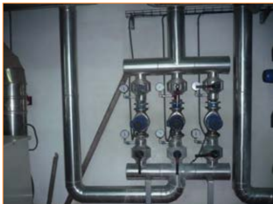
Imagen 29 Grupos de bombeo – Primario producción de calor (B10, B11 Y B12)
