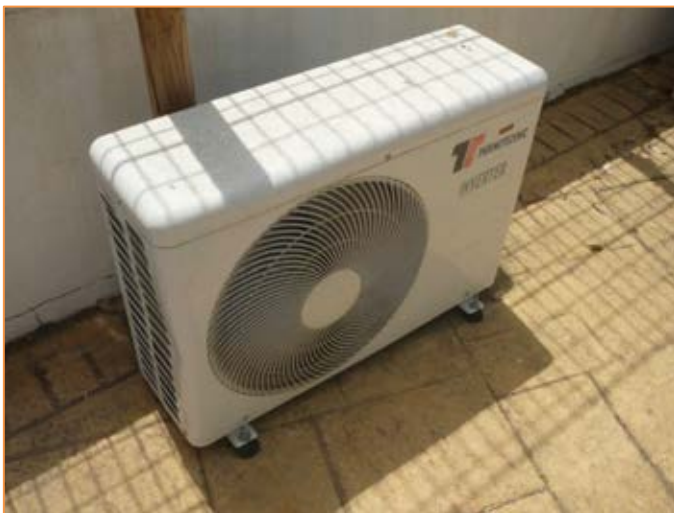
Imagen 20 Equipos de producción de frío y calor para climatización - Sistema autónomo de expansión directa tipo BdC Split 1x1
