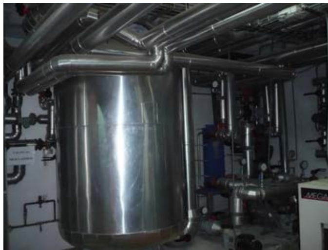
Imagen 52 Intercambiadores de calor – Calentamiento de vaso
