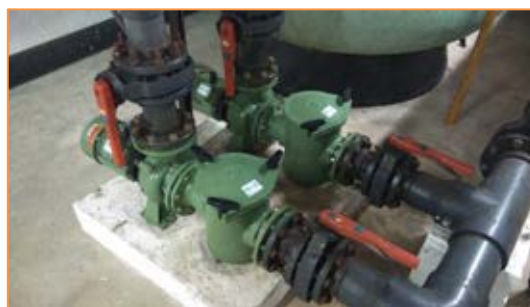
Imagen 55 Sistema de filtración (bombas de recirculación) – Vaso principal
