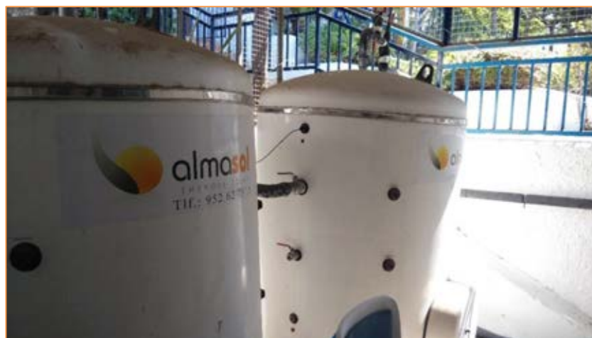
Imagen 15 Instalación solar térmica – Acumulación solar térmica
