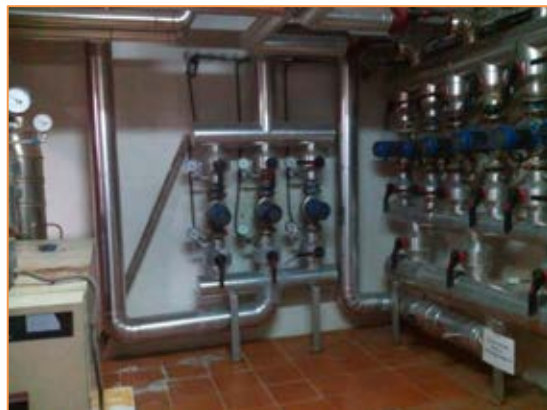
Imagen 29 Grupos de bombeo – Primario producción de calor (B10, B11 Y B12)
