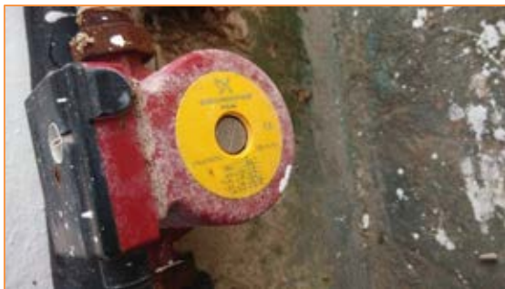
Imagen 24 Grupos de bombeo – Secundario solar térmica (B2 y B3)
