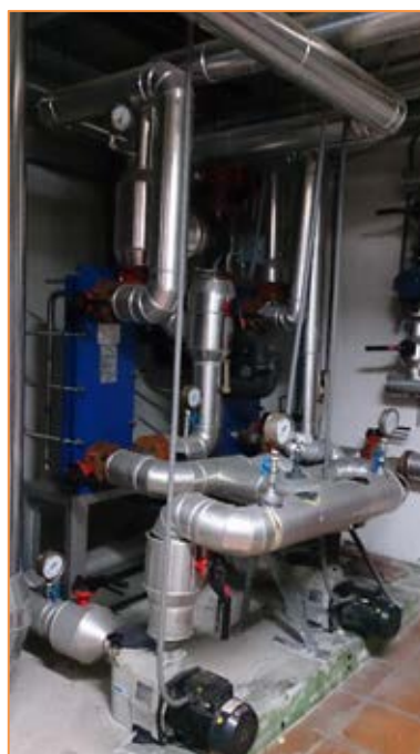
Imagen 31 Grupos de bombeo –Recirculación piscina (B21 y B22)
