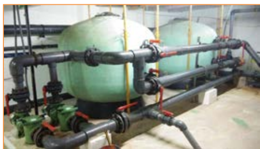
Imagen 54 Sistema de filtración (filtros de arena) – Vaso principal
