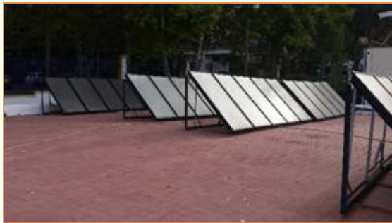
Imagen 13 Instalación solar térmica – Captadores solares planos
