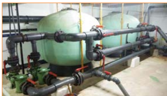
Imagen 33 Grupos de bombeo – Primario depuradora (B25 y B26)
