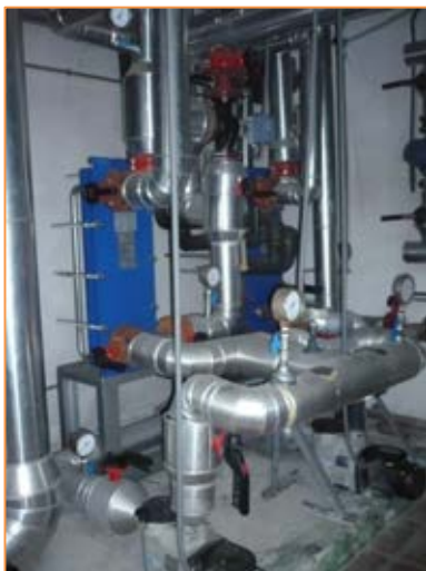
Imagen 52 Intercambiadores de calor – Calentamiento de vaso
