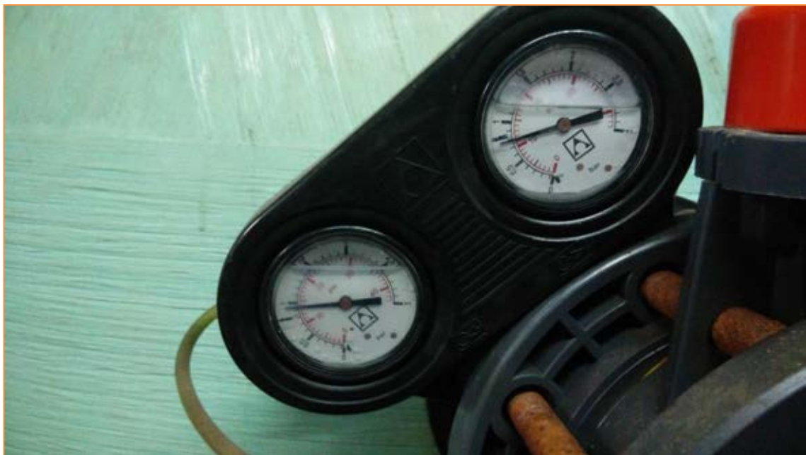
Imagen 57 Manómetro diferencial - Filtro
