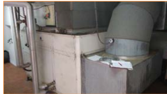
Imagen 22 Equipos de producción de frío y calor para climatización - Deshumectadora
