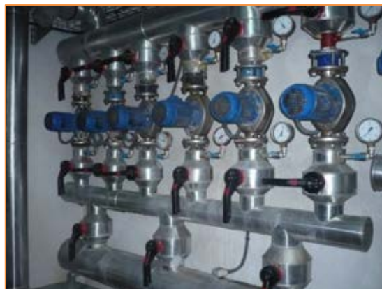
Imagen 30 Grupos de bombeo – Primario piscina, ACS, radiadores y condensación deshumectadora (B13, B14, B15, B16, B17, B18, B19, B20)
