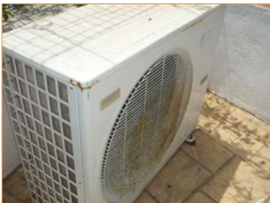
Imagen 21 Equipos de producción de frío y calor para climatización - Sistema autónomo de expansión directa tipo BdC Split 1x1
