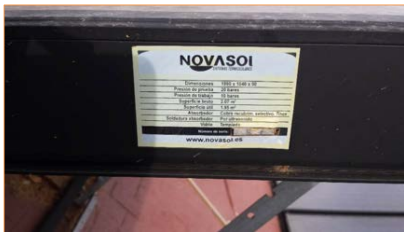
Imagen 14 Instalación solar térmica – Captadores solares planos
