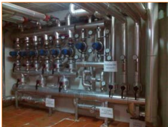
Imagen 30 Grupos de bombeo – Primario piscina, ACS, radiadores y condensación deshumectadora (B13, B14, B15, B16, B17, B18, B19, B20)
