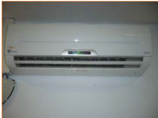
Imagen 40 Tipología de unidades interiores instaladas - Pared
