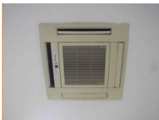
Imagen 39 Tipología de unidades interiores instaladas – Cassette y conductos
