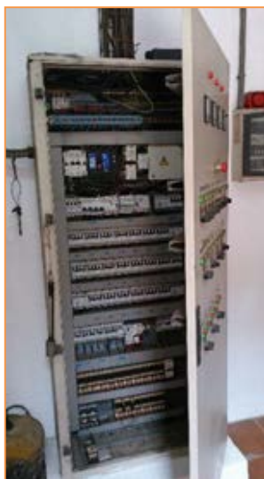
Imagen 11 Cuadro eléctrico y de control - Central de producción
