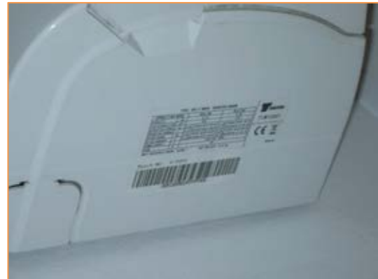
Imagen 40 Tipología de unidades interiores instaladas - Pared
