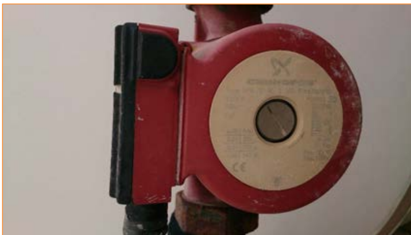
Imagen 26 Grupos de bombeo – Secundario solar térmica (B5)
