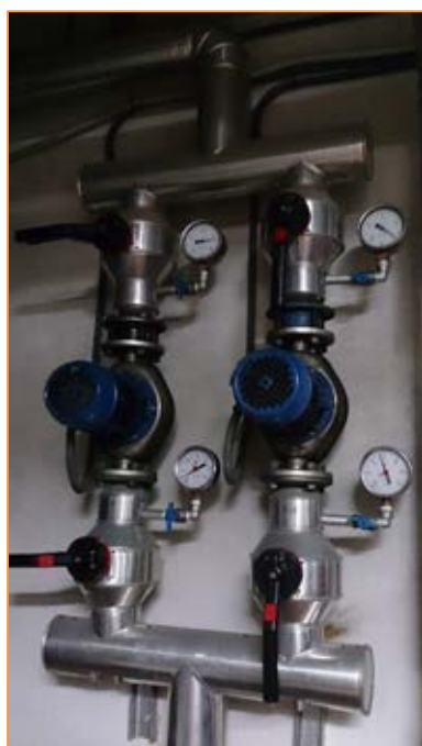
Imagen 36 Grupos de bombeo – Grupo de presión de agua caliente sanitaria (B31 y B32)
