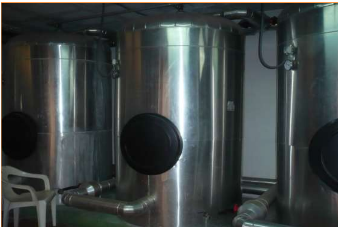
Fotografía 65. Depósitos acumuladores Cuarto de Calderas
