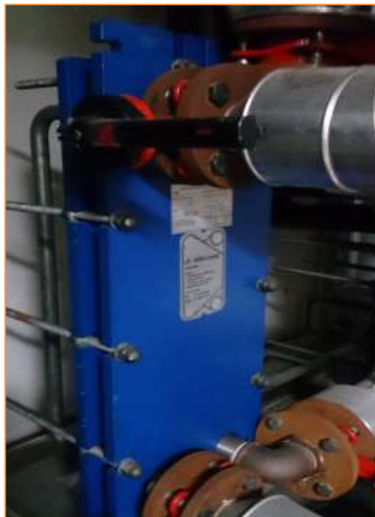
Fotografía 63. Intercambiador de calor por placas Cuarto de Calderas
