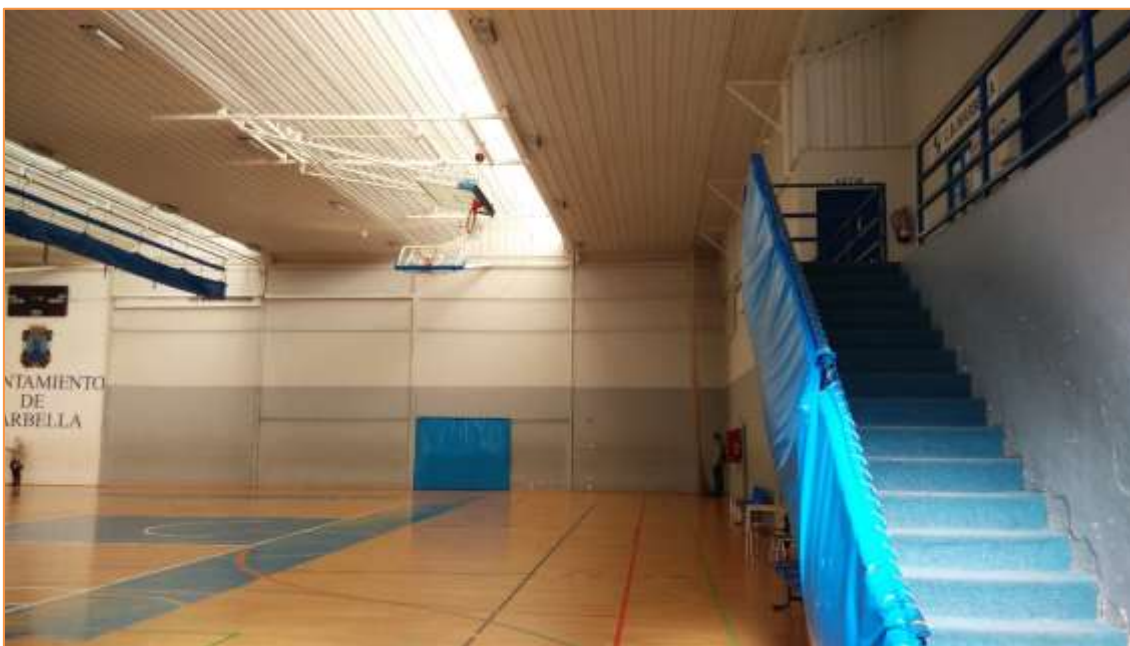
Fotografía 47. Vista interior. Cubierta Panel Sándwich
