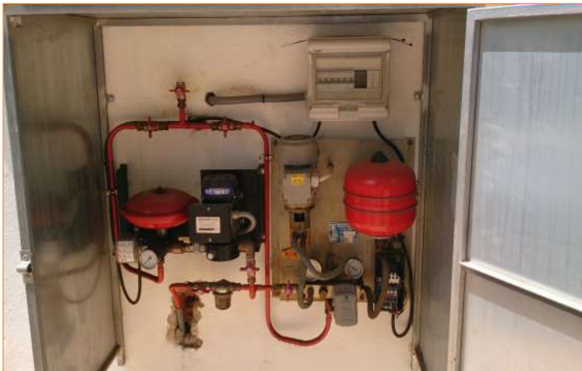
Fotografía 66. Bomba de Gasoil en Cubierta
