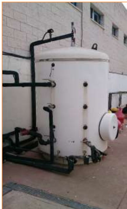
Fotografía 14. Depósito de Solar Térmica
