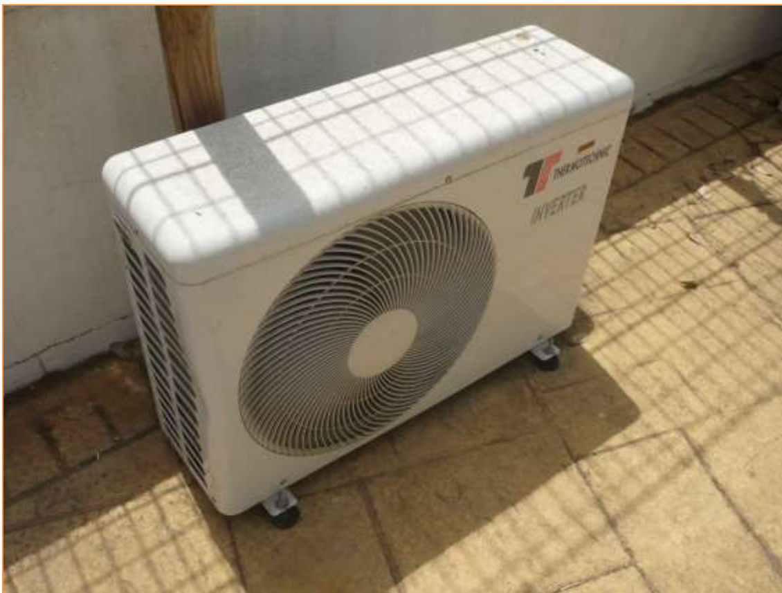
Fotografía 60. Sistema autónomo de expansión directa tipo BdC. Despacho Instalaciones Deportivas
