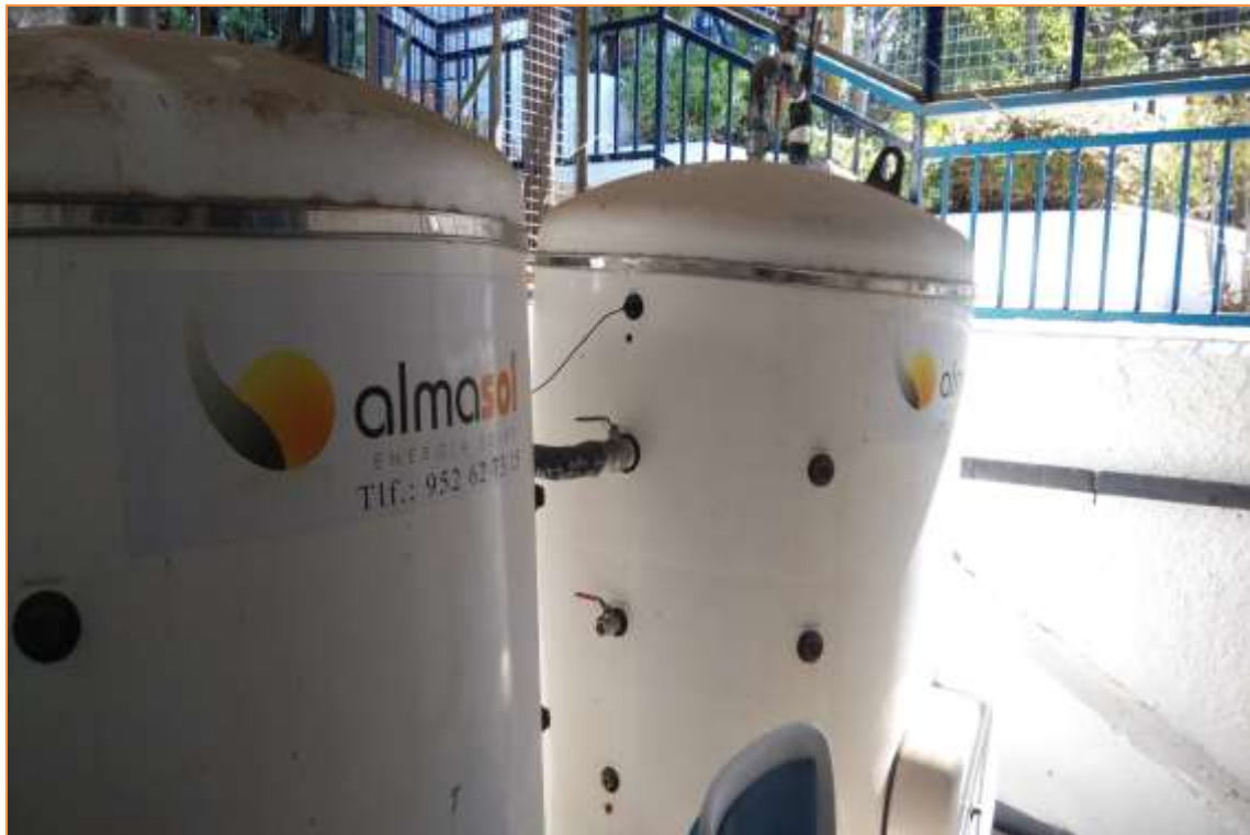
Fotografía 45. Depósitos Solar-térmica
