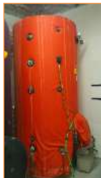
Imagen 19 Termos acumuladores eléctricos– Sala de termos
