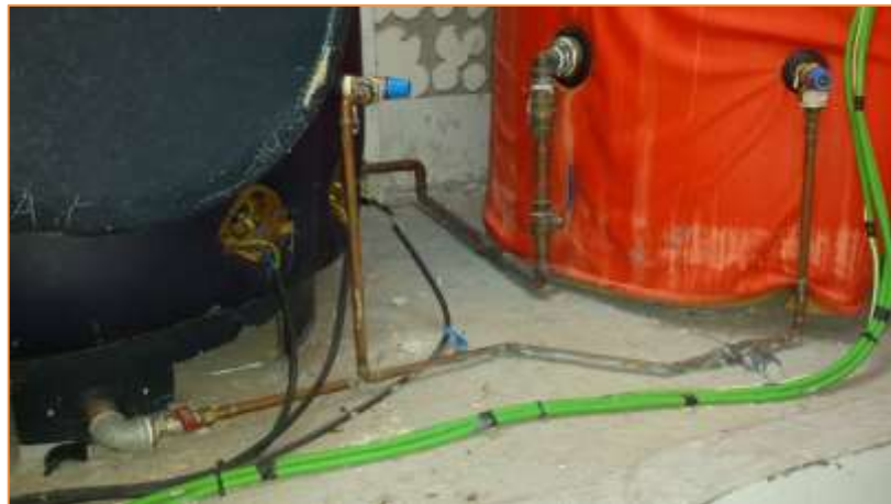
Imagen 6 Termos acumuladores eléctricos– Sala de termos
