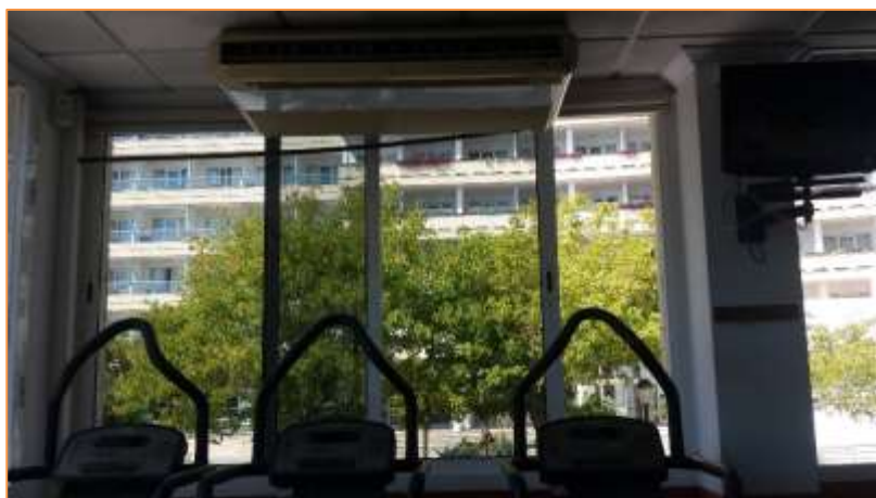
Imagen 10 Tipología de unidades interiores instaladas - Unidad interior –Split tipo techo - Gimnasio
