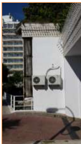
Imagen 7 Equipos de producción de frío y calor para climatización – Sistema autónomo de expansión directa sólo frío - Fachada Este
