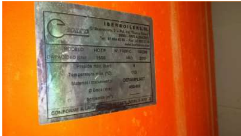
Imagen 5 Termos acumuladores eléctricos– Sala de termos
