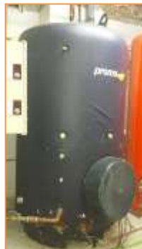
Imagen 18 Termos acumuladores eléctricos – Sala de termos
