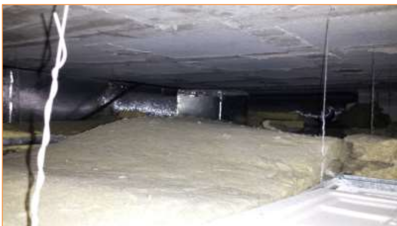
Imagen 11 Tipología de unidades interiores instaladas - Unidad interior –Split tipo conductos - Gimnasio
