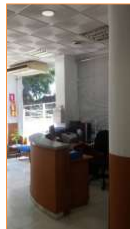
Imagen 9 Tipología de unidades interiores instaladas – Unidad interior –Split tipo techo - Recepción
