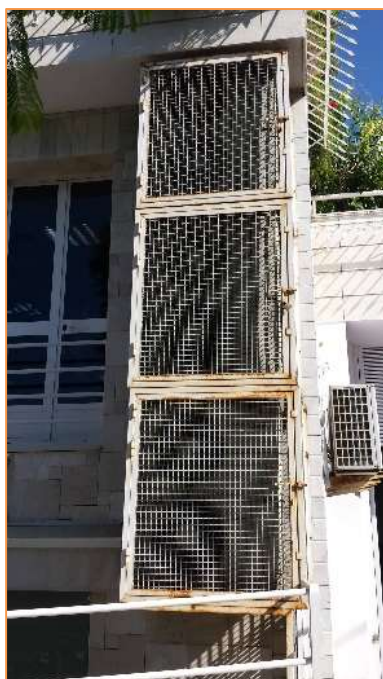
Imagen 8 Equipos de producción de frío y calor para climatización– Sistema autónomo de expansión directa BdC - Fachada Sur
