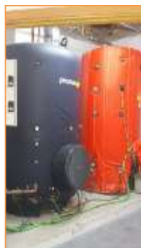
Imagen 20 Termos acumuladores eléctricos– Sala de termos
