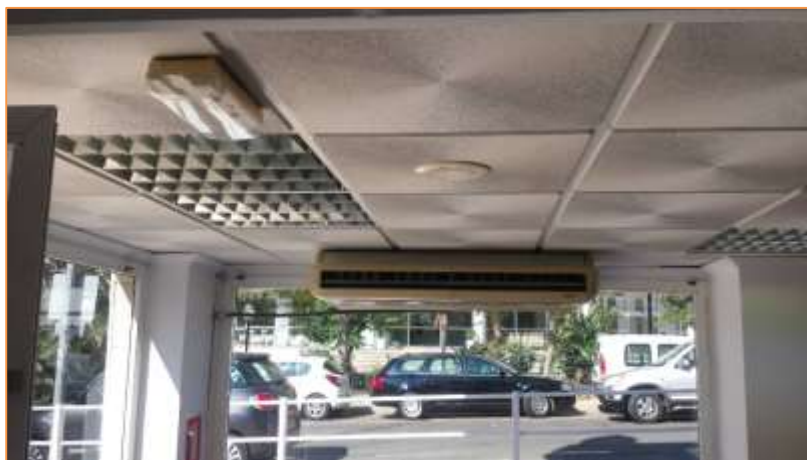
Imagen 9 Tipología de unidades interiores instaladas – Unidad interior –Split tipo techo - Recepción
