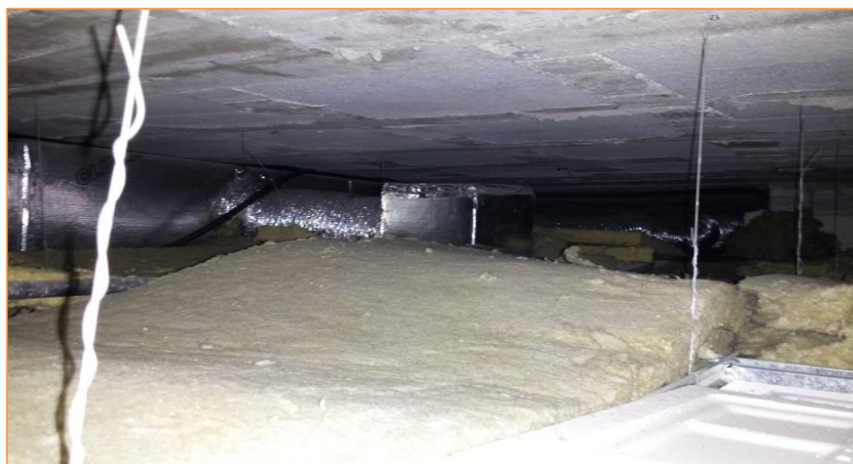
Fotografía 31 Unidades interiores splits conductos
