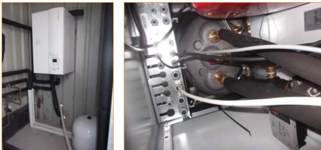
Imagen 7 Instalación de apoyo para generación de ACS
