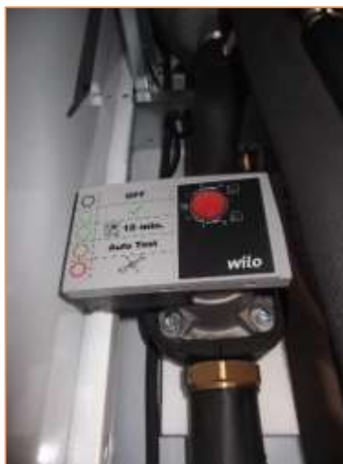
Imagen 9 Grupos de bombeo – Primario producción de calor
