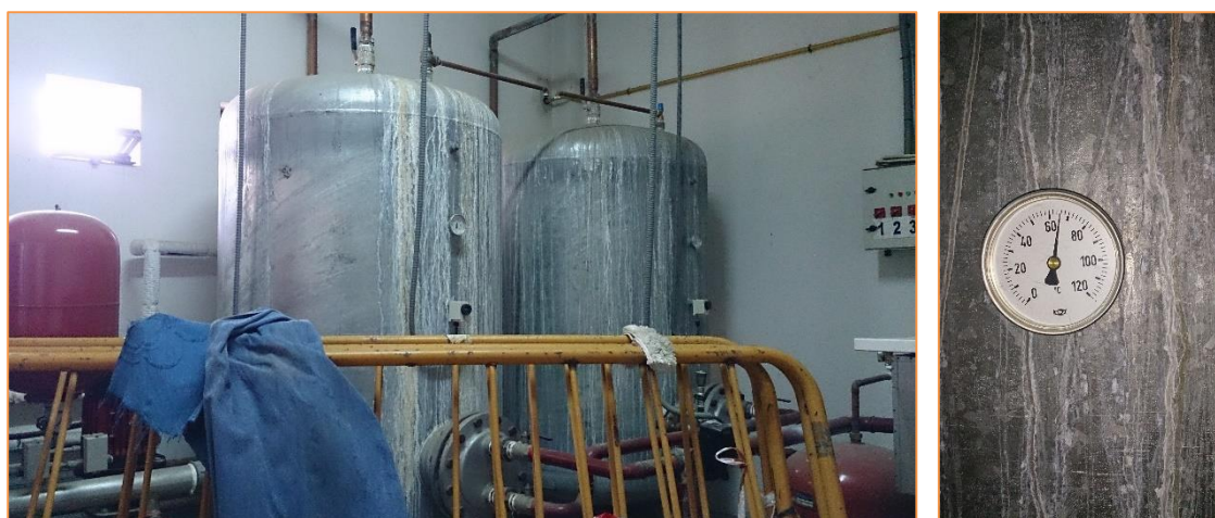
Imagen 12 Instalación de apoyo para generación de ACS – Acumuladores de calor (2.000 + 2.000 litros)
