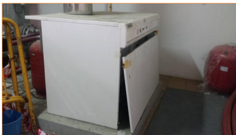
Imagen 5 Sala de calderas – Caldera atmosférica
