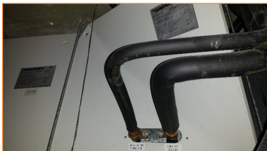
Imagen 27 Tipología de unidades interiores instaladas – De conductos – Sala de usos múltiples 2
