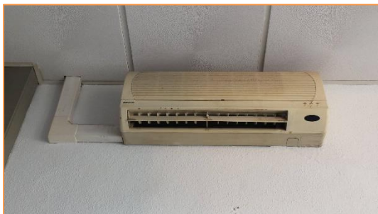
Imagen 25 Tipología de unidades interiores instaladas – De pared – Conserjería y despacho
