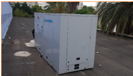
Imagen 15 Equipos de producción de frío y calor para climatización – Gimnasio antiguo
