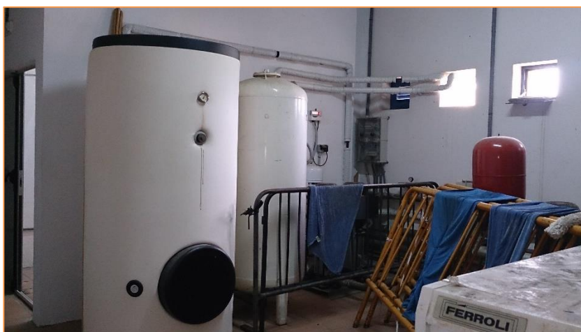
Imagen 9 Sala de calderas – Acumulación de ACS – Solar térmica
