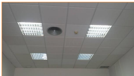
Imagen 29 Tipología de unidades interiores instaladas – Elementos de difusión y elementos de control
