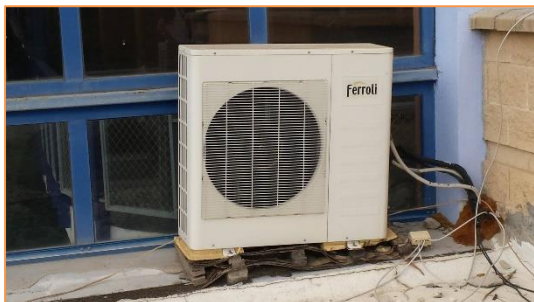
Imagen 19 Equipos de producción de frío y calor para climatización – Bar
