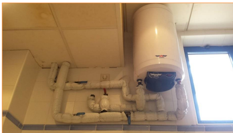
Imagen 14 Termo acumulador eléctrico – Aseos oficinas defensor del menor
