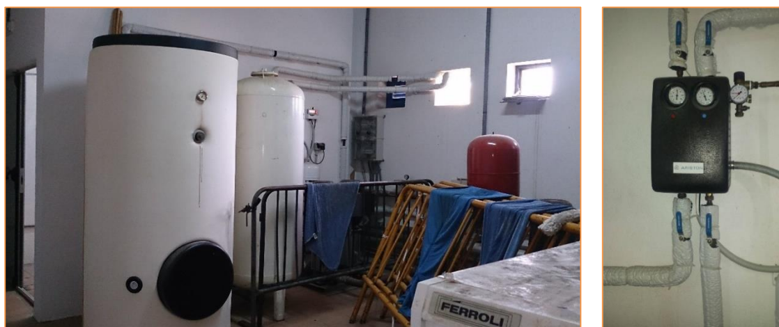
Imagen 11 Instalación solar térmica 1 – Depósito de acumulación solar (888 litros) y circuito primario solar
