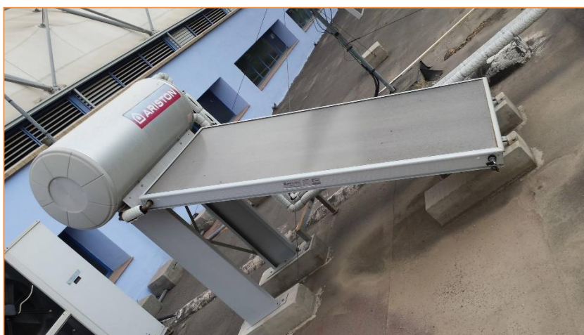
Imagen 13 Instalación solar térmica 2 – Termosifón – Oficinas del defensor del menor
