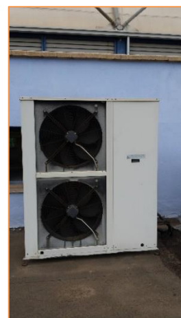
Imagen 16 Equipos de producción de frío y calor para climatización – Sala de usos múltiples 1 y 2
