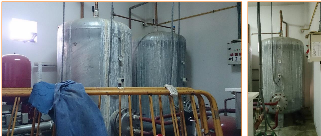
Imagen 40 Estado de aislamiento – Depósitos de acumulación de ACS sin aislamiento
