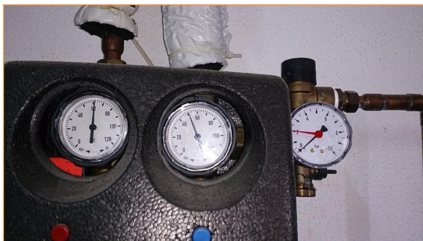
Imagen 22 Grupos de bombeo – Primario solar térmica – B4
