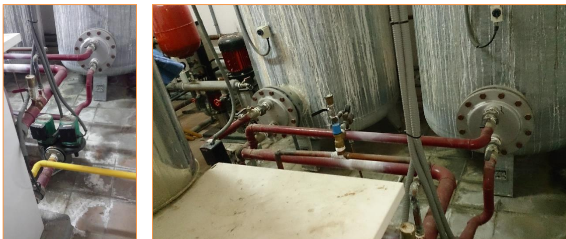
Imagen 41 Estado de aislamiento – Tuberías y valvulería
