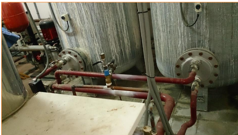
Imagen 7 Sala de calderas – Distribución térmica – Primario de ACS
