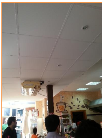
Imagen 26 Tipología de unidades interiores instaladas – De techo – Conserjería y despacho
