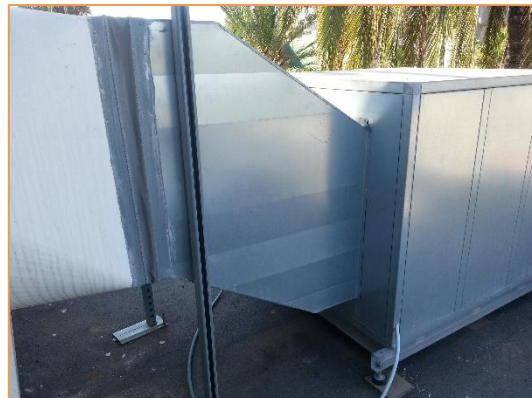
Imagen 31 Tipología de UTAs instaladas – Sistema de extracción de pistas - Extractor
