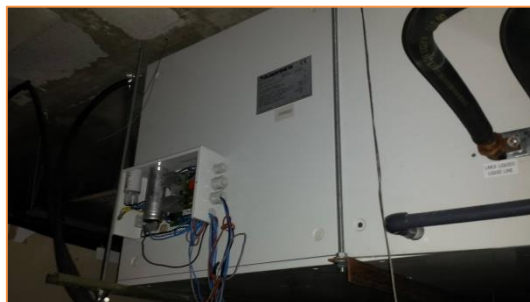
Imagen 27 Tipología de unidades interiores instaladas – De conductos – Sala de usos múltiples 2
