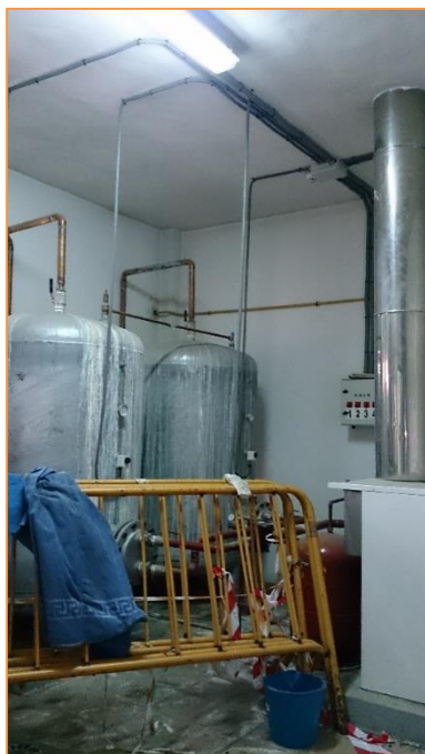
Imagen 8 Sala de calderas – Acumulación de ACS – Producción desde caldera
