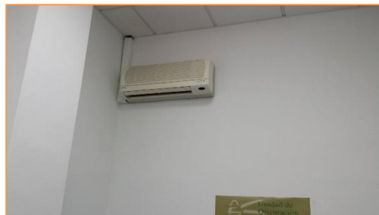
Imagen 25 Tipología de unidades interiores instaladas – De pared – Conserjería y despacho
