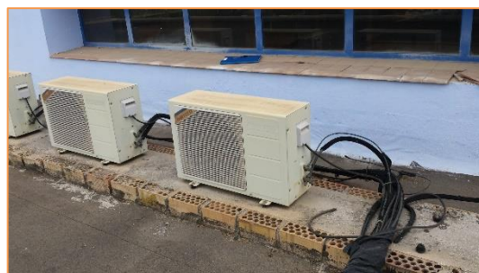
Imagen 17 Equipos de producción de frío y calor para climatización – Despachos 1, 2 y 4
