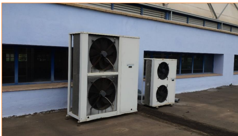
Imagen 16 Equipos de producción de frío y calor para climatización – Sala de usos múltiples 1 y 2
