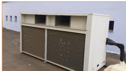
Imagen 15 Equipos de producción de frío y calor para climatización – Gimnasio antiguo
