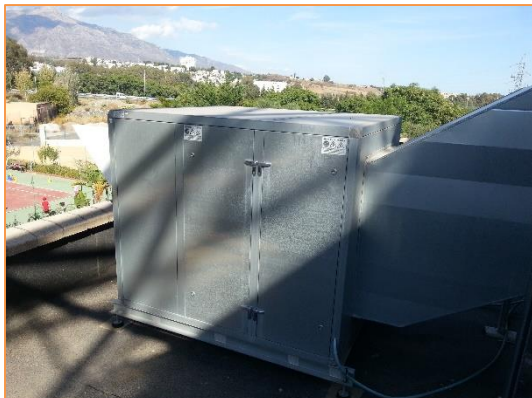
Imagen 31 Tipología de UTAs instaladas – Sistema de extracción de pistas - Extractor
