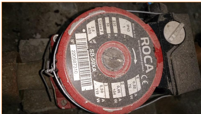
Imagen 21 Grupos de bombeo – Bomba de recirculación ACS – B1
