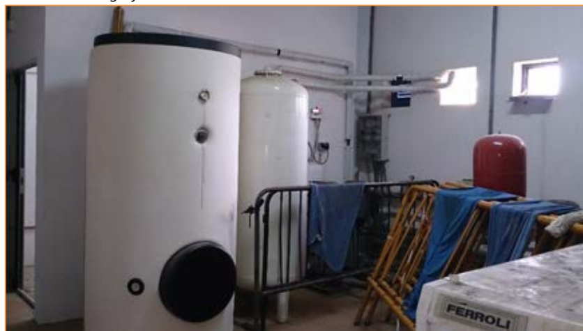
Fotografía 86. Acumulación de ACS – Solar térmica
