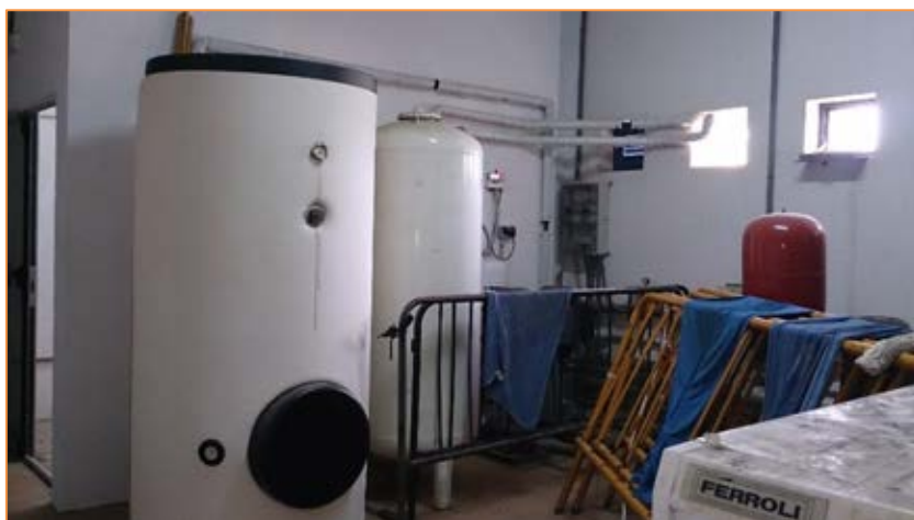
Fotografía 88. Depósito de acumulación solar (888 litros) y circuito primario solar
