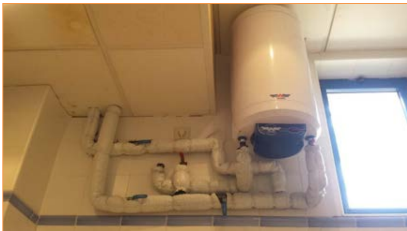
Fotografía 89. Termoacumulador eléctrico
