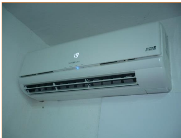
Imagen 7 Tipología de unidades interiores instaladas
