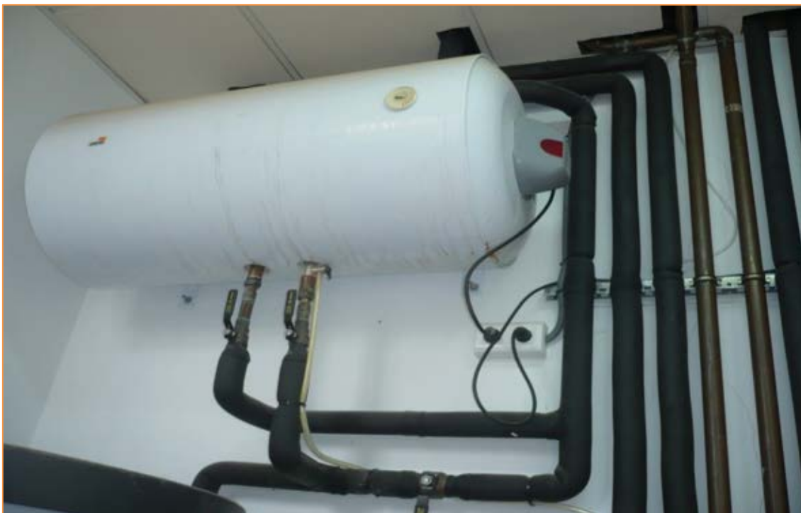
Fotografía 41. Termo-Acumulador eléctrico 'Edificio 2'
