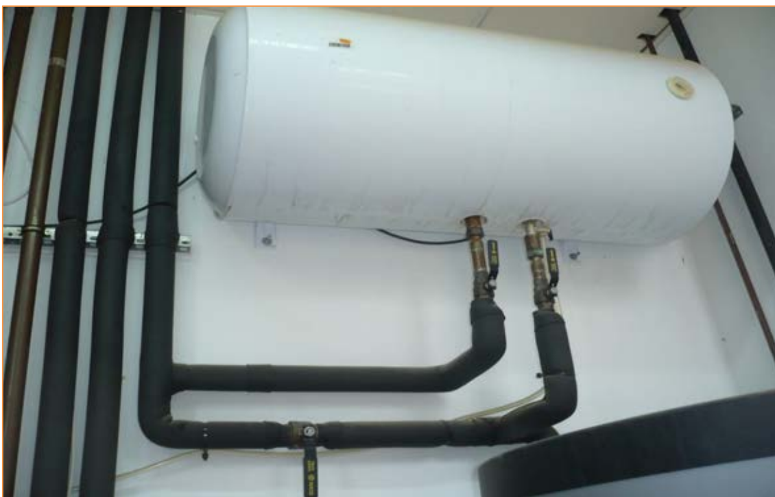
Fotografía 42. Termo-Acumulador eléctrico 'Edificio 2'
