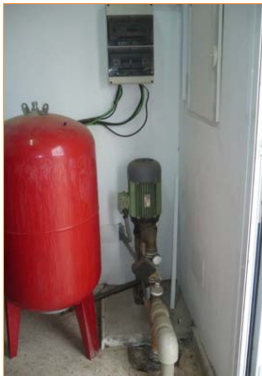
Fotografía 43. Bombas ACS 'Edificio 2'
