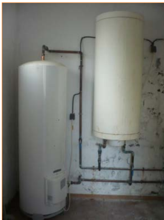
Fotografía 45. Termo eléctrico y Depósito acumulador 'Edificio 3'
