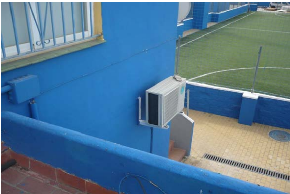
Fotografía 47. Unidades exteriores Splits Cubierta 'Edificio 5'
