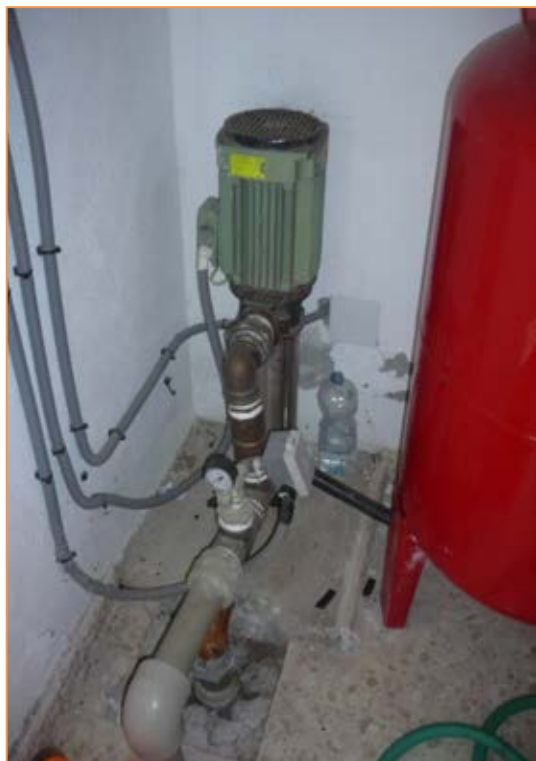
Fotografía 43. Bombas ACS 'Edificio 2'
