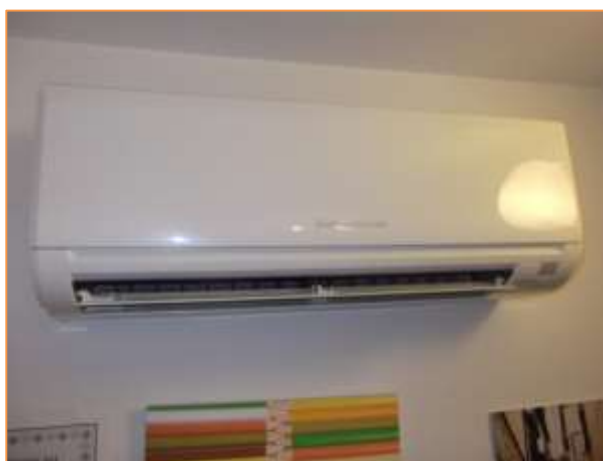
Imagen 6 Tipología de unidades interiores instaladas – Despacho de juventud – Tipo pared
