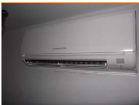
Imagen 5 Tipología de unidades interiores instaladas – Dirección de juventud – Tipo pared
