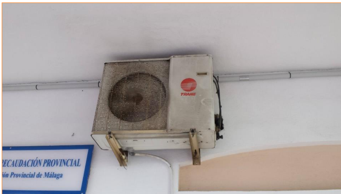
Fotografía 19. Unidades exteriores Splits Fachada
