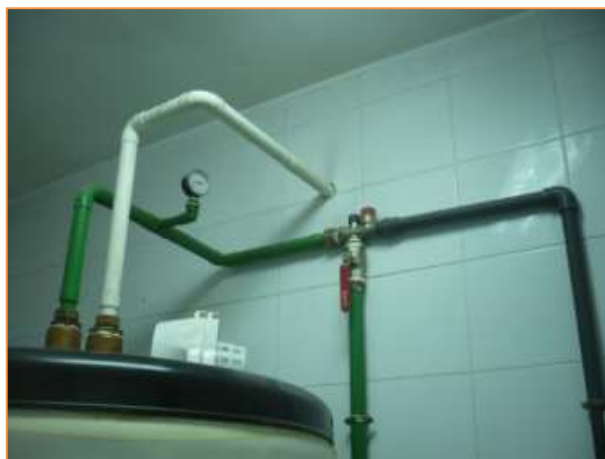
Imagen 18 Termo acumulador eléctrico – Cuarto de limpieza
