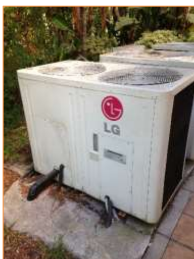
Imagen 9 Equipos de producción de frío y calor para climatización – LG P08AH UTO
