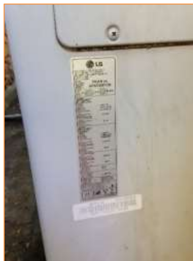
Imagen 10 Equipos de producción de frío y calor para climatización – LG P05AH UTO
