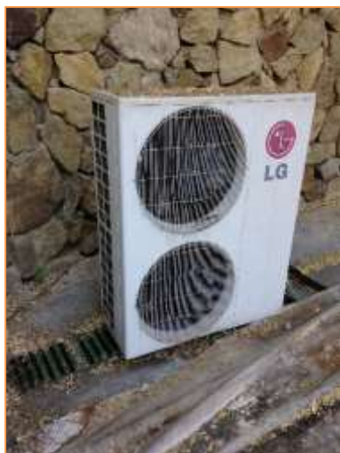
Imagen 10 Equipos de producción de frío y calor para climatización – LG P05AH UTO
