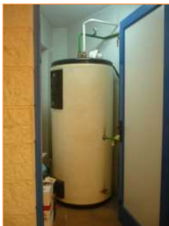
Imagen 18 Termo acumulador eléctrico – Cuarto de limpieza
