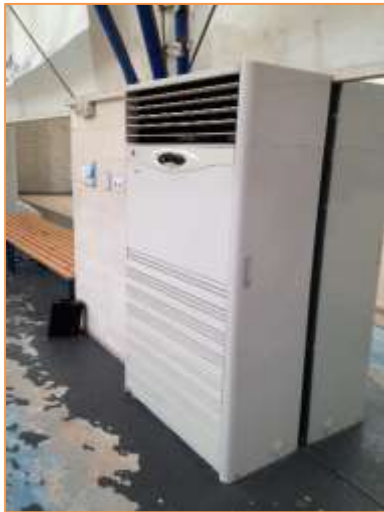
Imagen 11 Tipología de unidades interiores instaladas - Unidad interior- -Split tipo suelo - LG P08AH UFO
