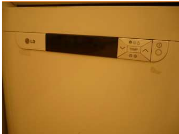
Imagen 12 Tipología de unidades interiores instaladas – Unidad interior- -Split tipo suelo - LG P05AH UTO
