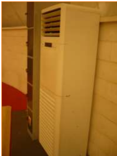
Imagen 12 Tipología de unidades interiores instaladas – Unidad interior- -Split tipo suelo - LG P05AH UTO
