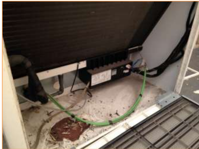
Imagen 11 Tipología de unidades interiores instaladas - Unidad interior- -Split tipo suelo - LG P08AH UFO
