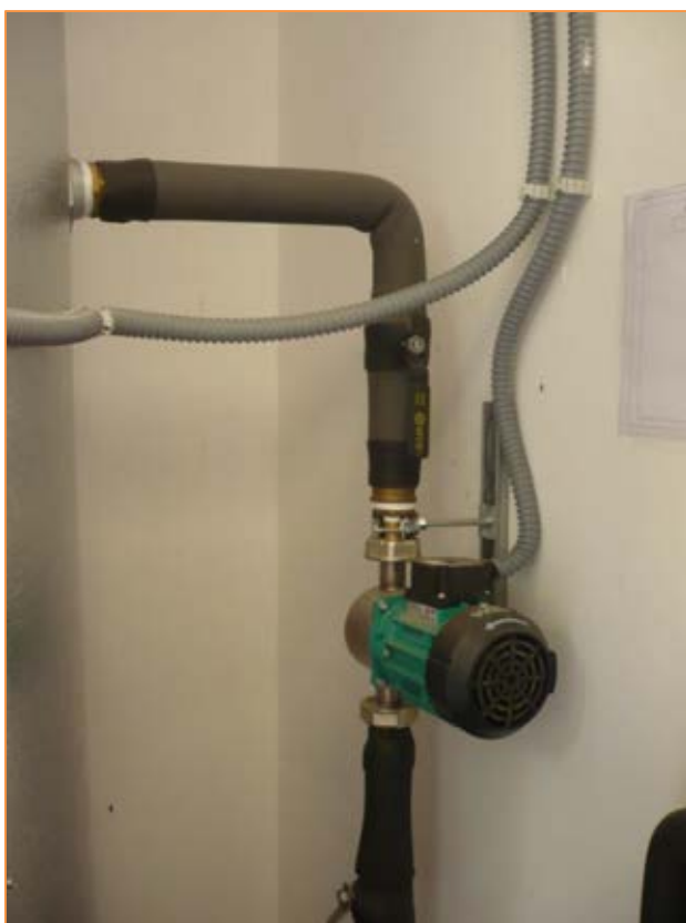
Fotografía 34. Bomba Circuito Secundario ACS
