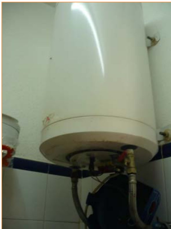
Fotografía 17. Termo acumulador eléctrico. Bar
