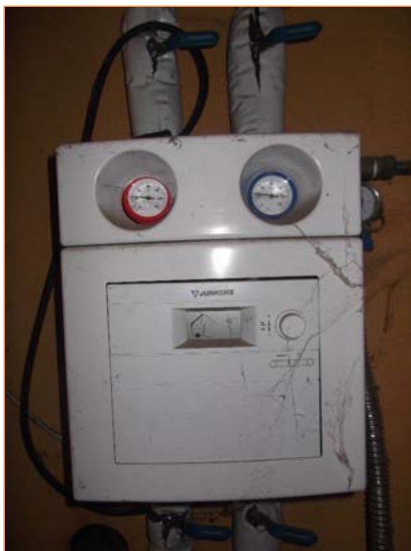
Fotografía 44. Bomba Primario Solar térmica. Pasillo Termos 1
