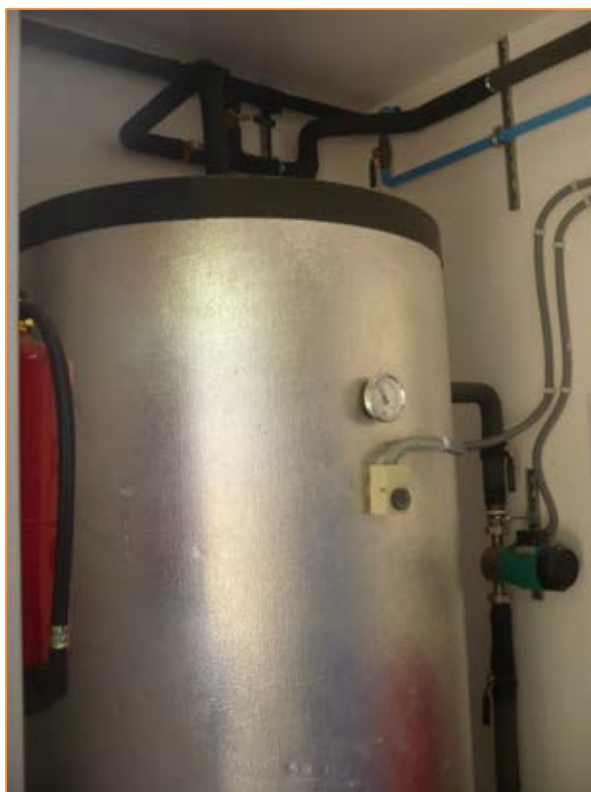
Fotografía 32. Depósito acumulador ACS Solar
