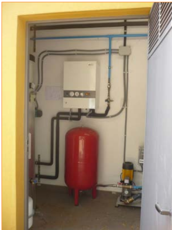
Fotografía 31. Caldera eléctrica. Sala de máquinas
