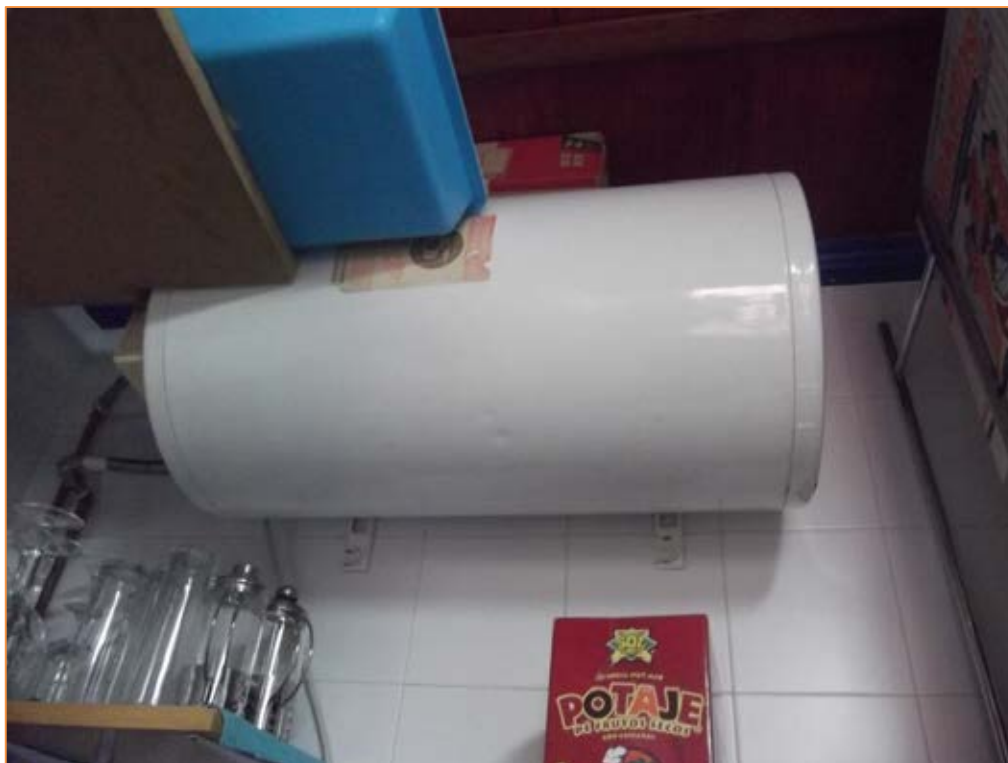
Fotografía 69. Termo acumulador eléctrico. Bar
