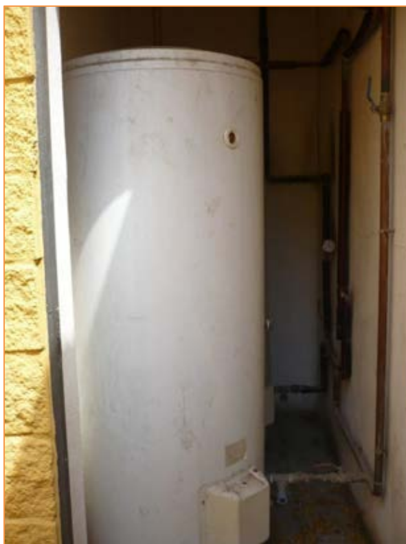
Fotografía 18. Termo acumuladores eléctricos. Sala Termos
