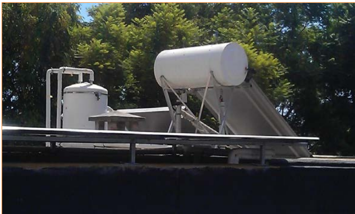
Fotografía 20. Instalación Solar térmica
