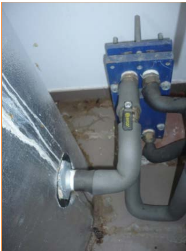
Fotografía 33. Intercambiador de Placas
